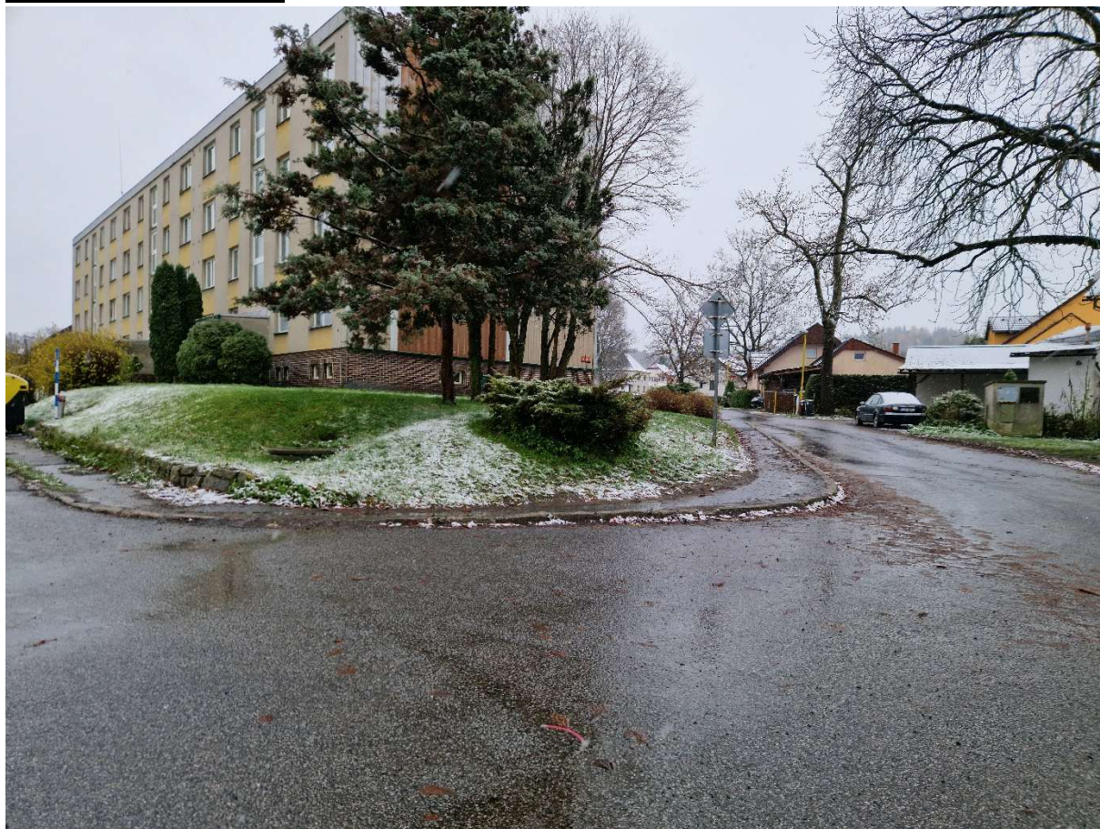
Foto současného stavu:
