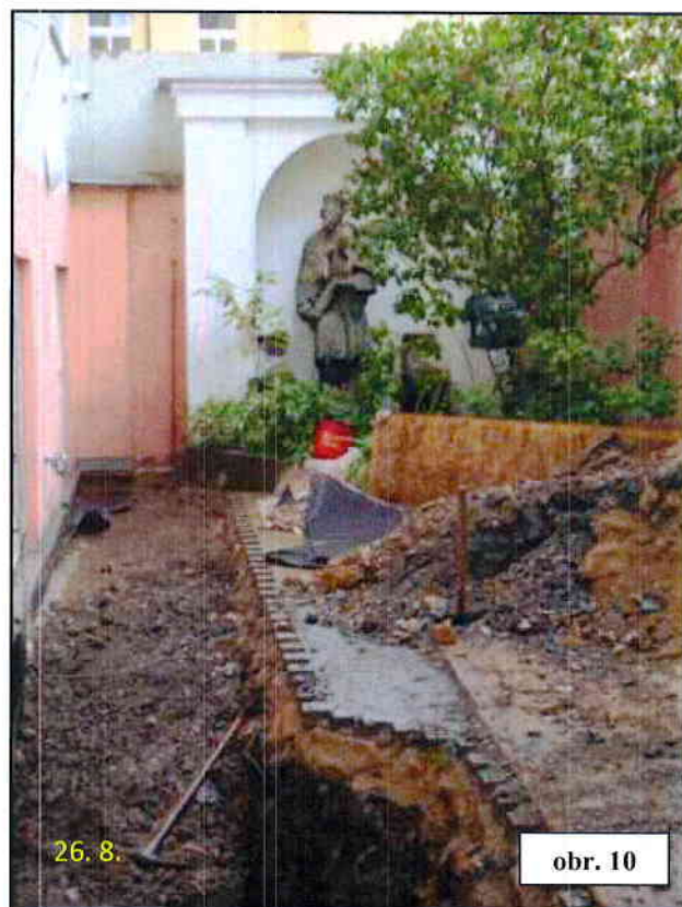
detail a celkový pohled na stávající konstrukci dvora (betonová dlažba 60 mm, podkladní beton až 200 mm)
