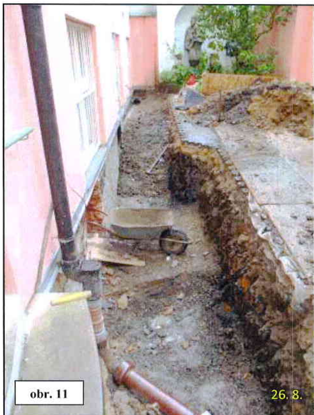
celkový pohled na rozpracovanou drenážní rýhu a základ zdvižné plošiny, pohled od schodiště k severu
