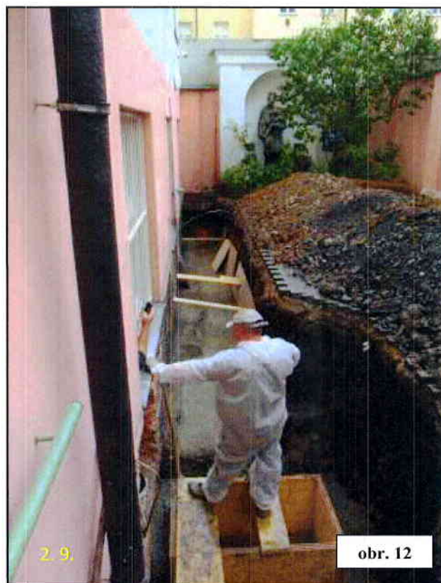
dtto obr. 11, betonování základu šachty pro zdvižnou plošinu a podklad pro osazení drenáže zadní části rýhy
