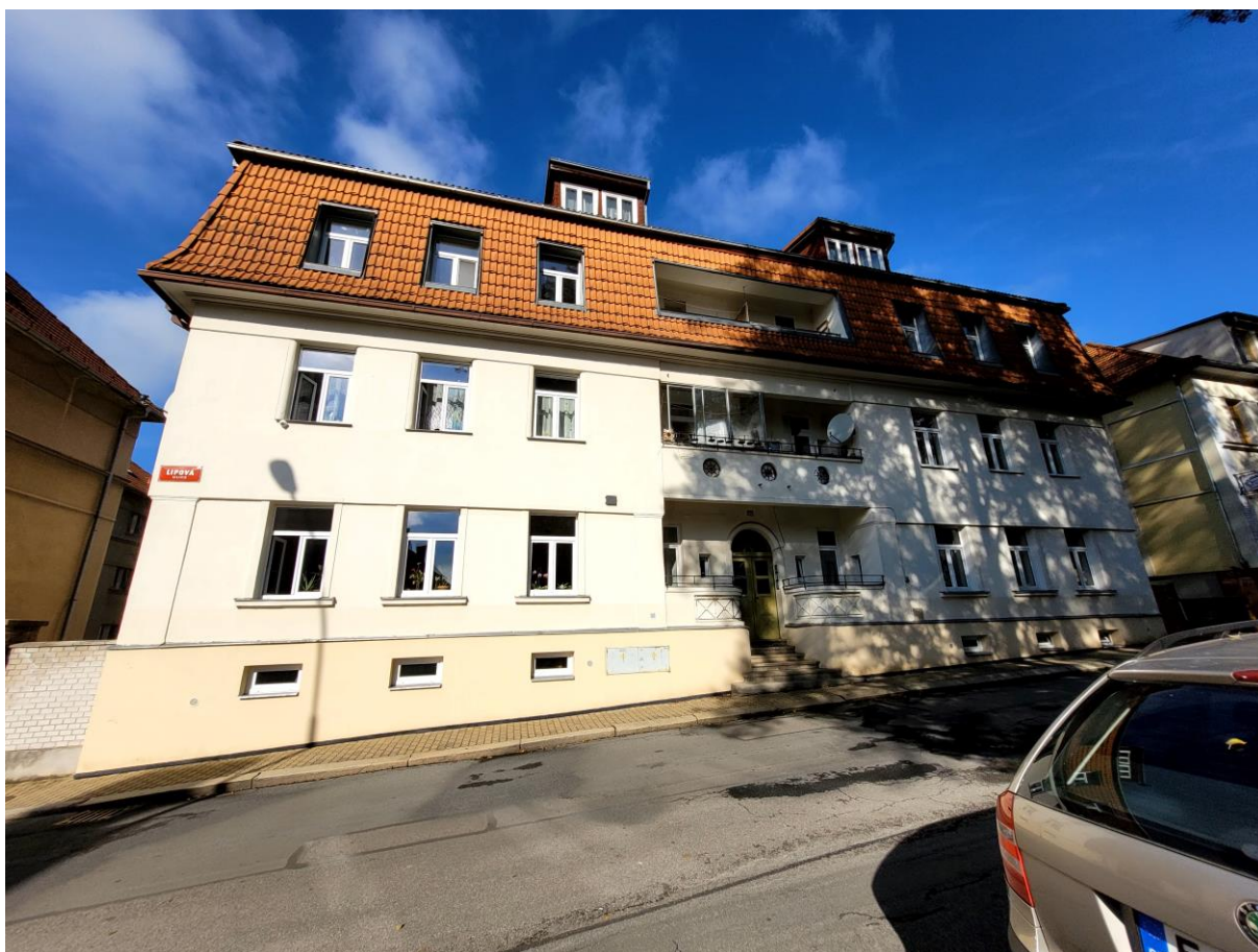
Obrázek 66: Bytový dům – společné prostory, Lipová 489
