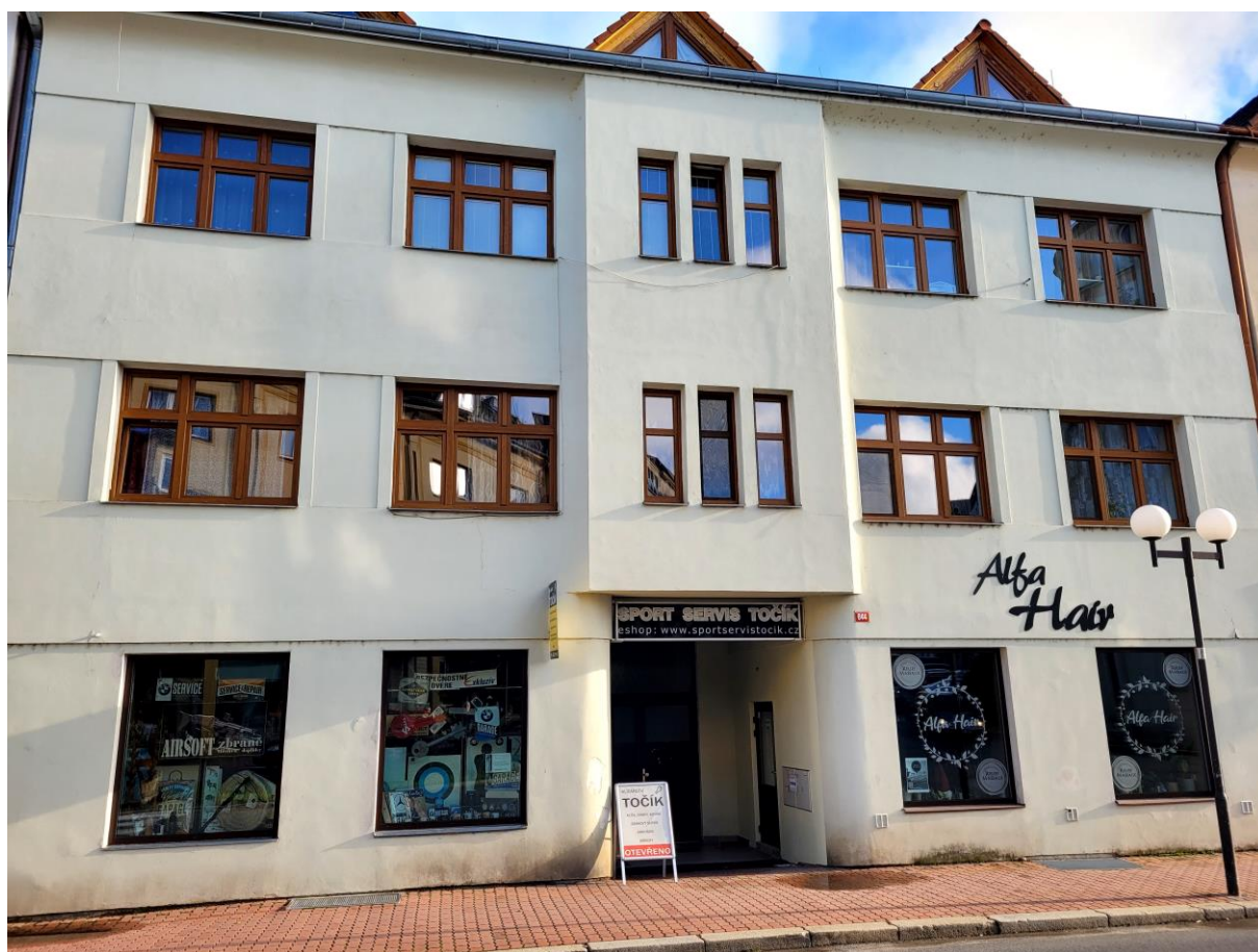
Obrázek 50: Bytový dům – společné prostory, Křemešnická 644
