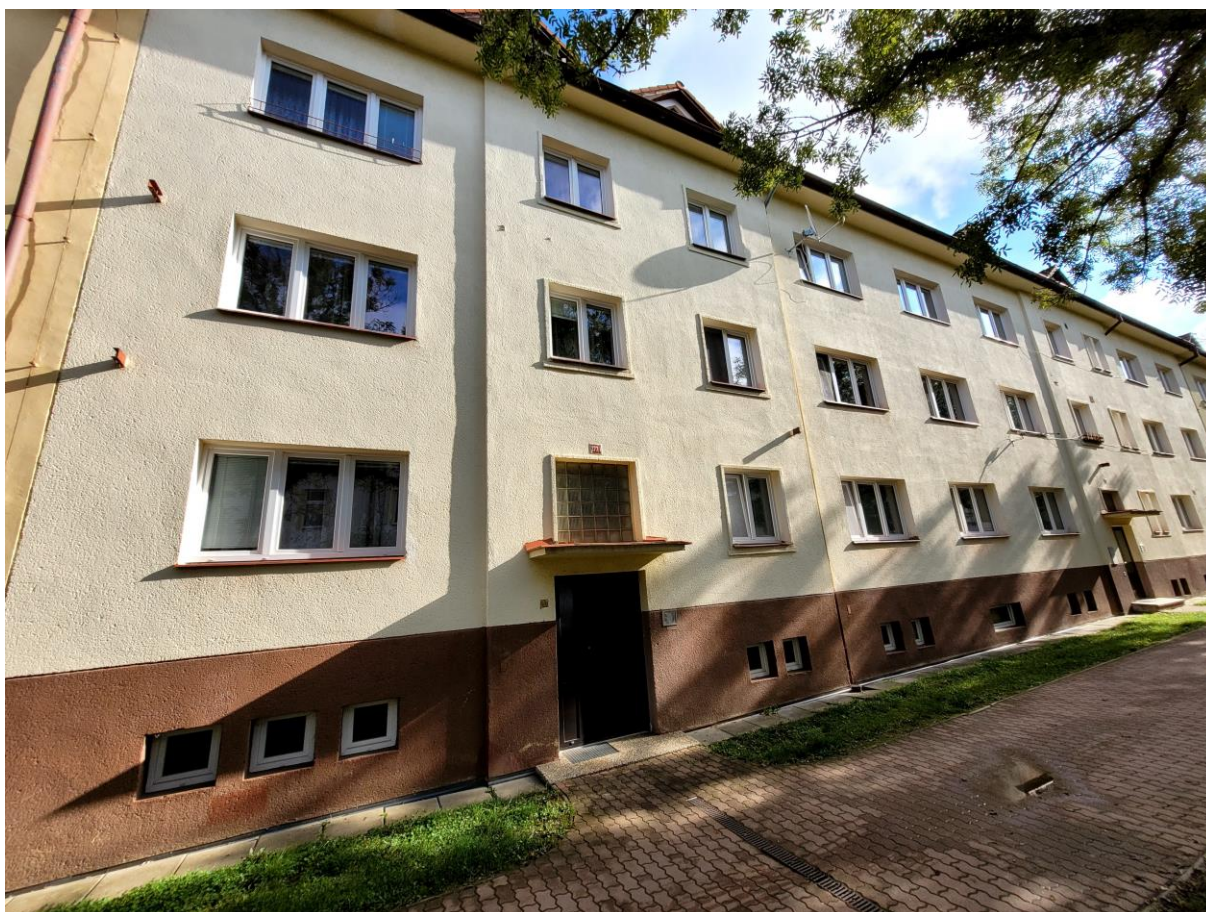
Obrázek 64: Bytový dům – společné prostory, Třída legií 277
