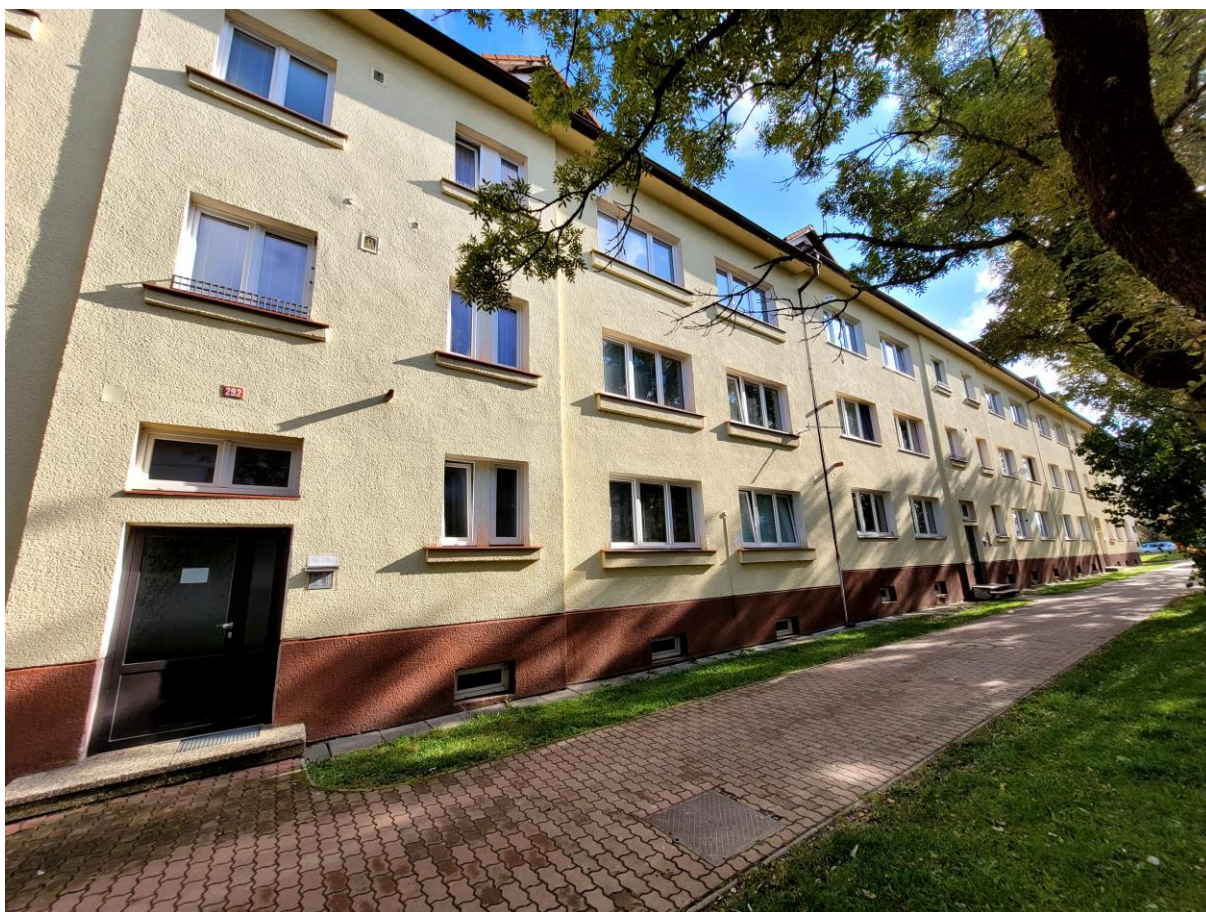
Obrázek 62: Bytový dům – společné prostory, Třída legií 292
