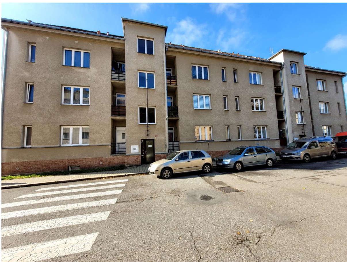
Obrázek 79: Bytový dům – společné prostory, Říčanského 560
