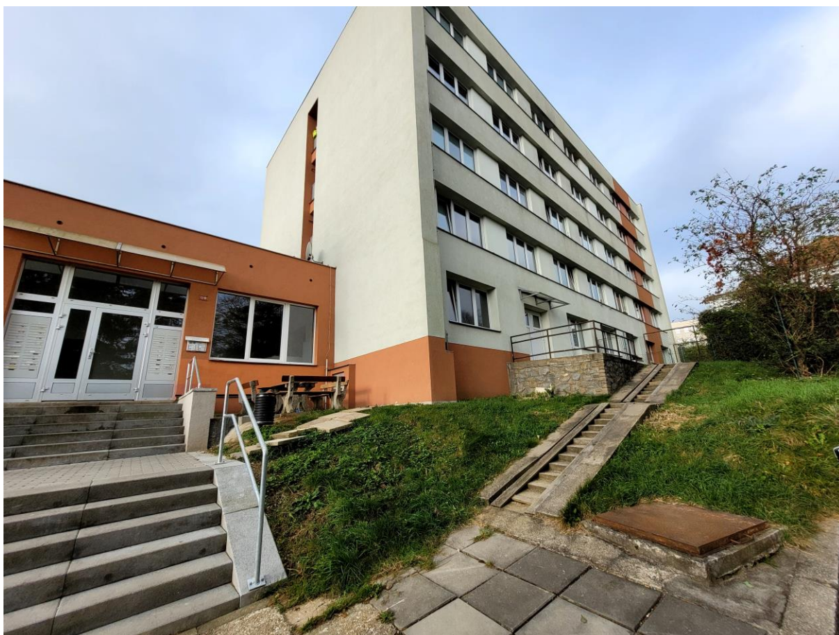
Obrázek 44: Bytový dům – společné prostory, Pražská 1318
