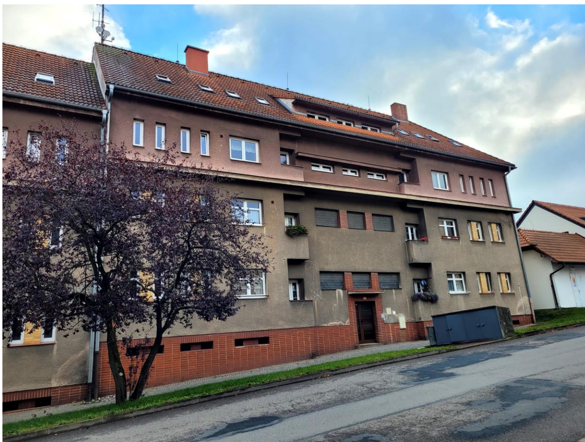
Obrázek 55: Bytový dům – společné prostory, Nádražní 903
