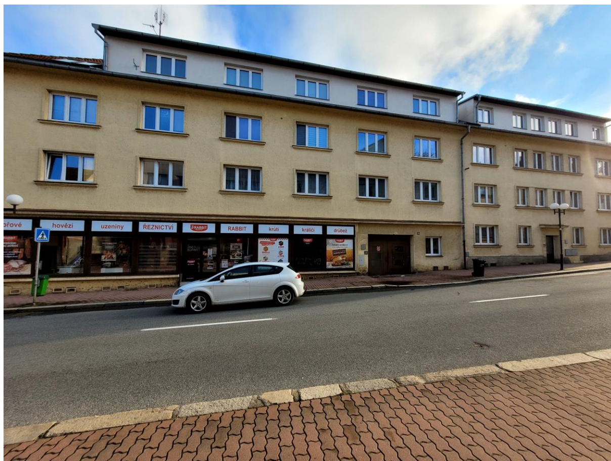
Obrázek 52: Bytový dům – společné prostory, Nádražní 813
