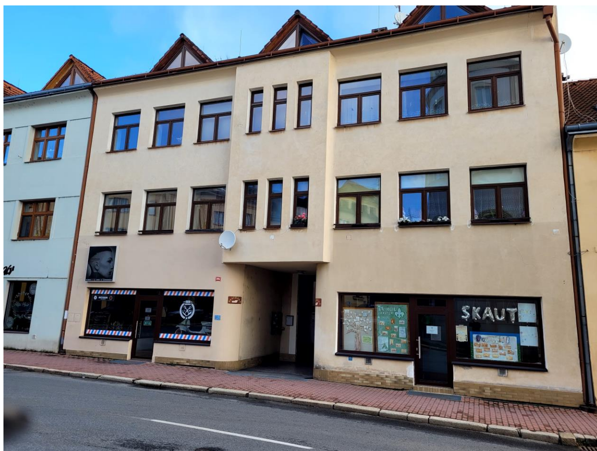
Obrázek 51: Bytový dům – společné prostory, Křemešnická 814
