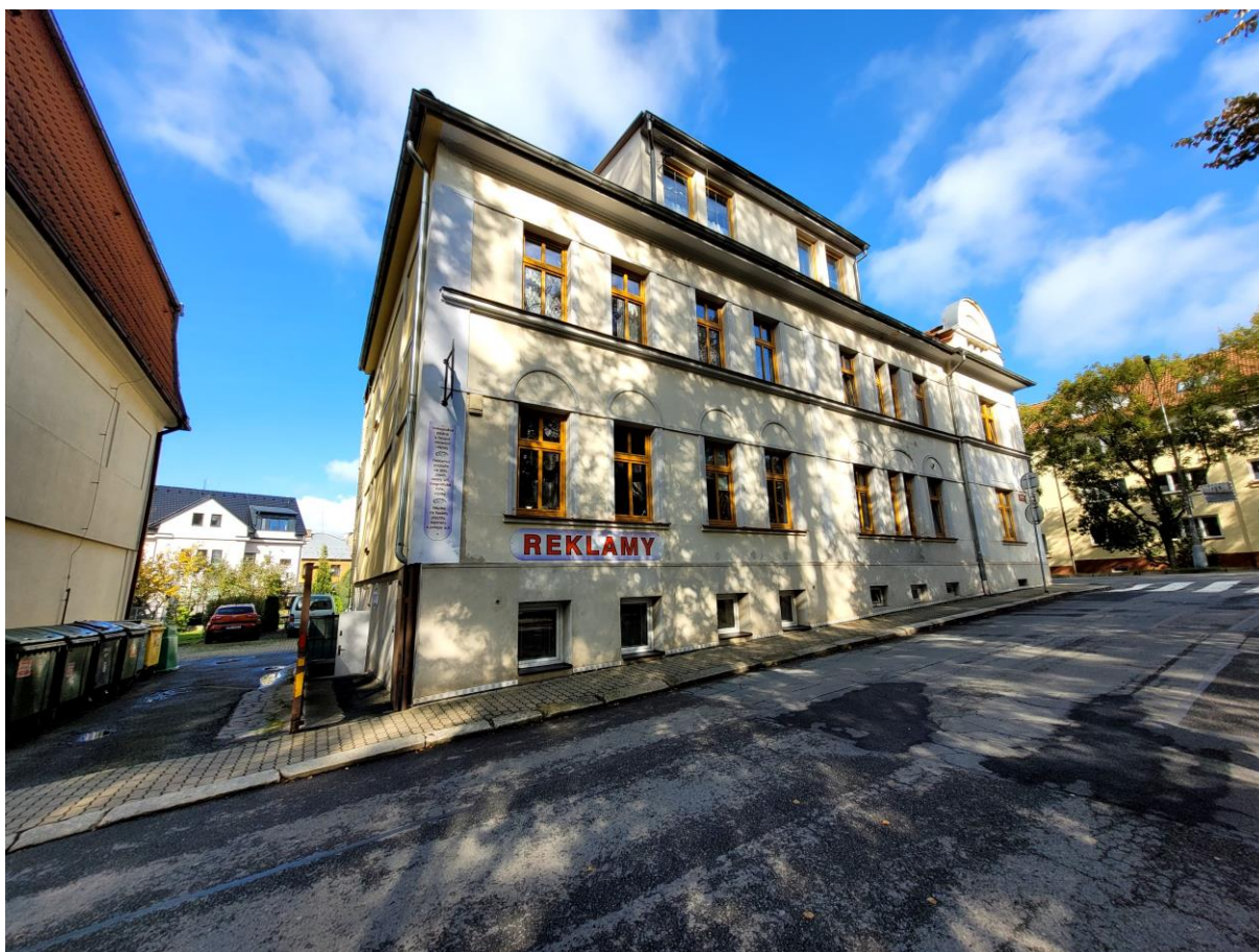
Obrázek 61: Bytový dům – společné prostory, Třída legií 488
