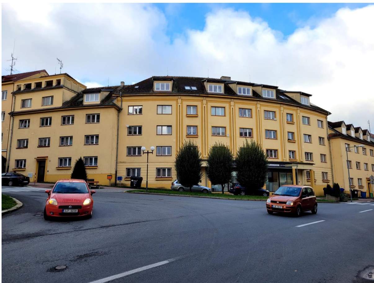
Obrázek 53: Bytový dům – společné prostory, Nádražní 826
