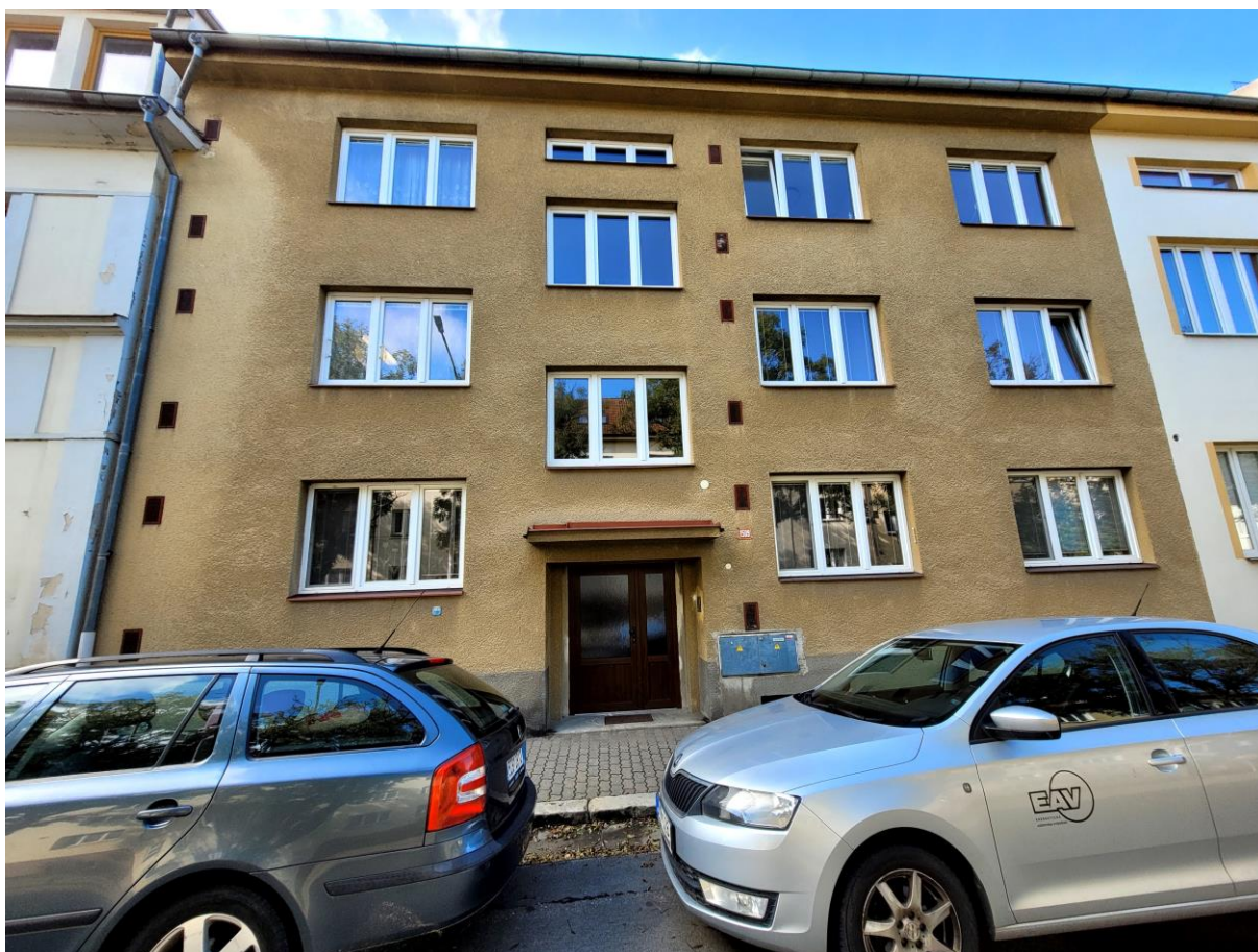
Obrázek 59: Bytový dům – společné prostory, Třída legií 1509
