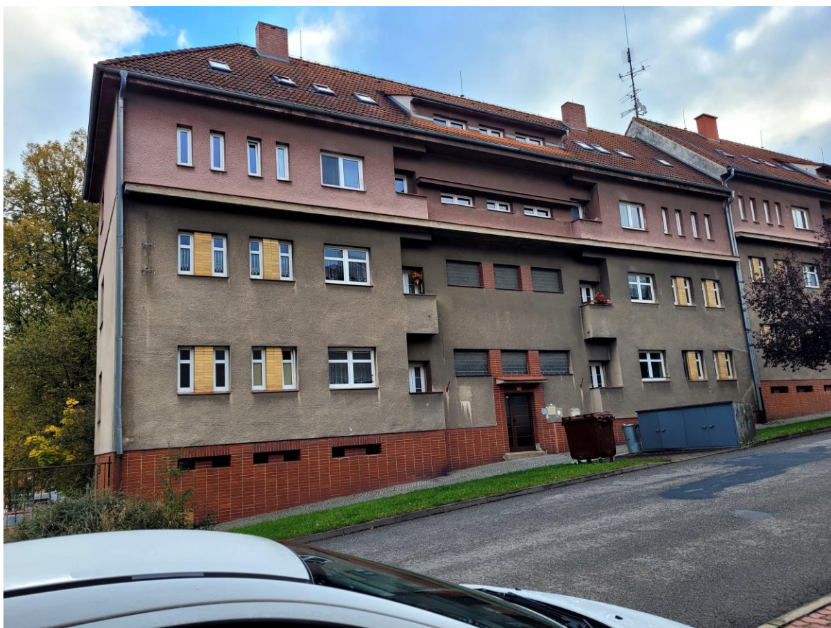
Obrázek 54: Bytový dům – společné prostory, Nádražní 902
