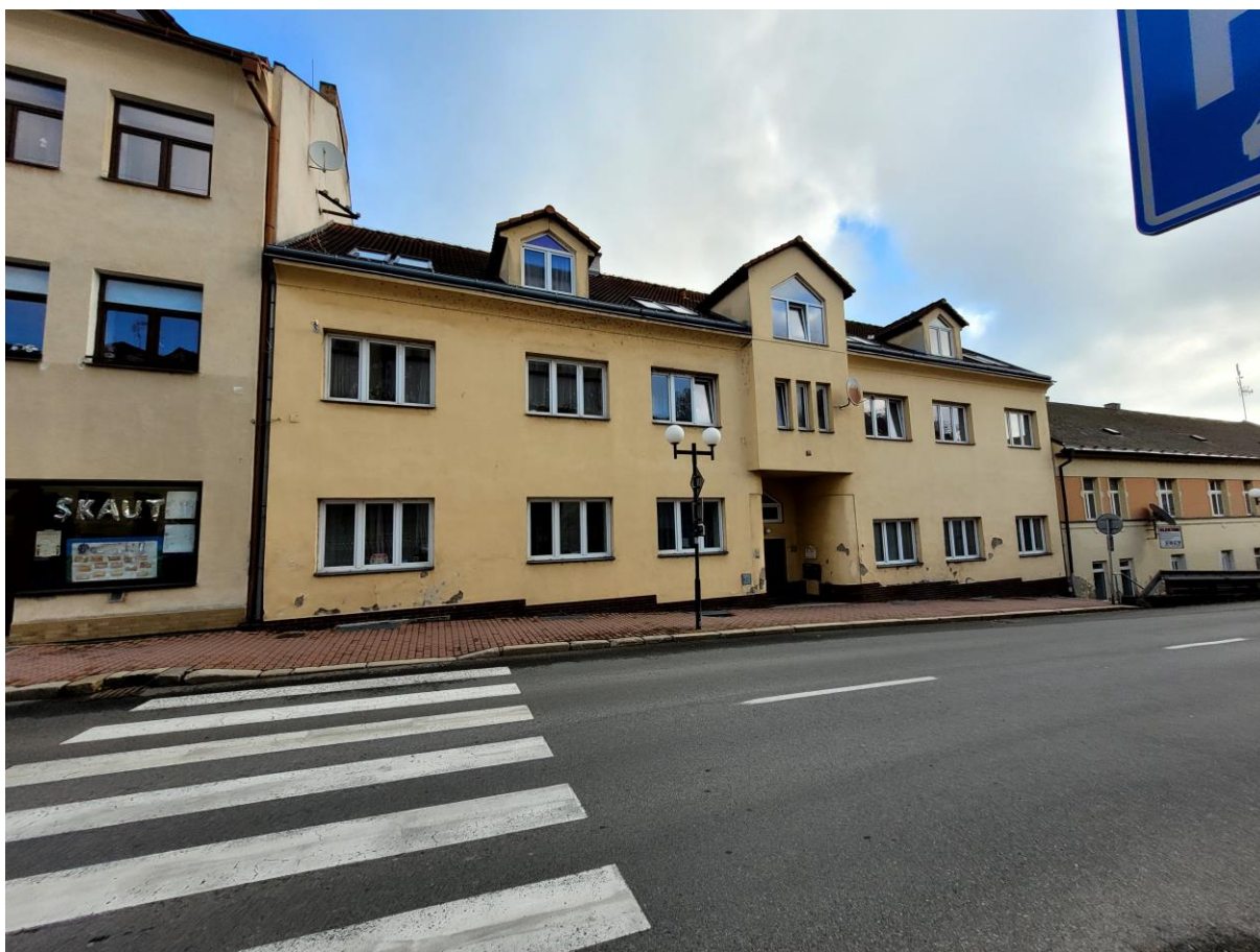
Obrázek 49: Bytový dům – společné prostory, Křemešnická 271
