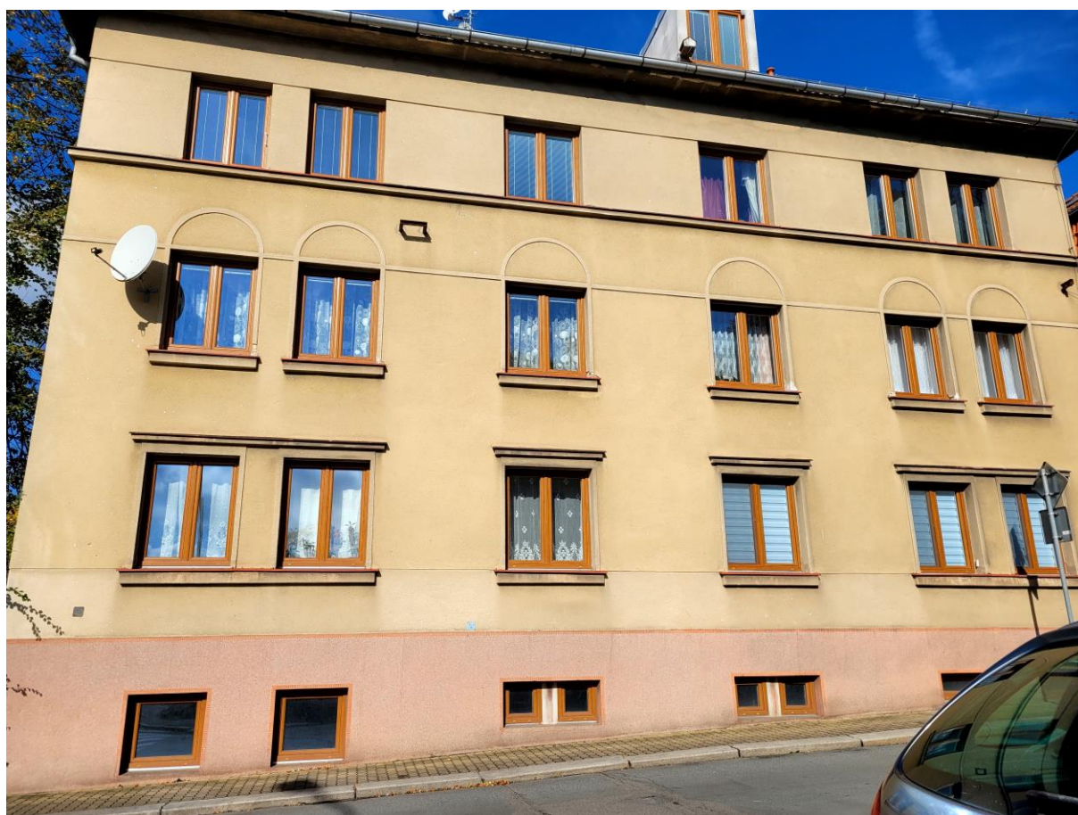
Obrázek 78: Bytový dům – společné prostory, Říčanského 223
