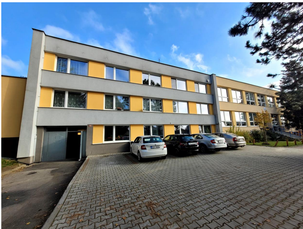
Obrázek 58: Bytový dům – společné prostory, Komenského 1466
