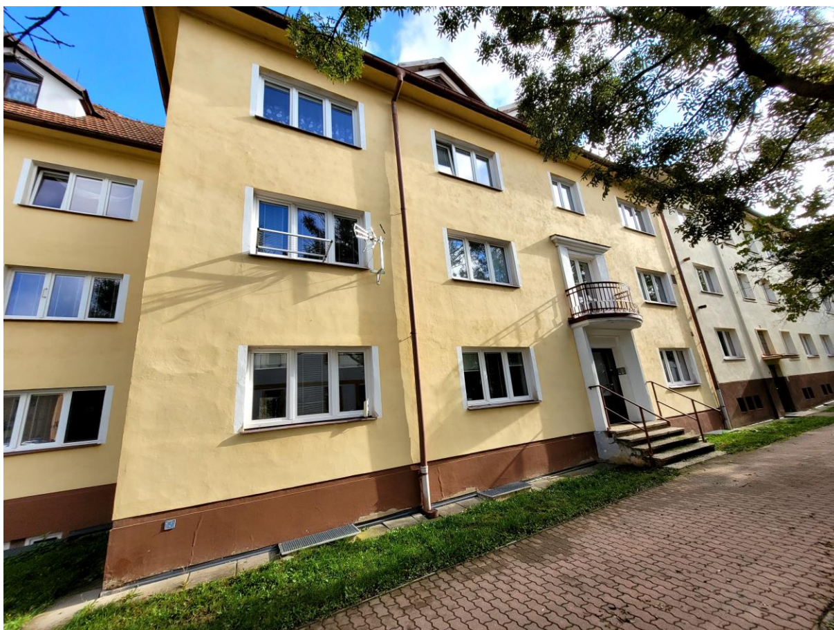
Obrázek 63: Bytový dům – společné prostory, Třída legií 276
