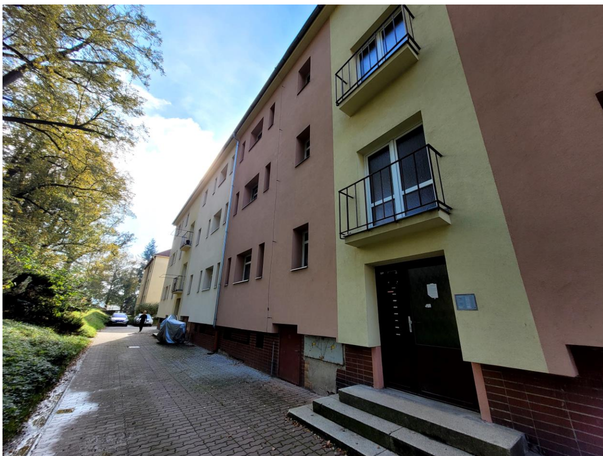
Obrázek 80: Bytový dům – společné prostory, Říčanského 817
