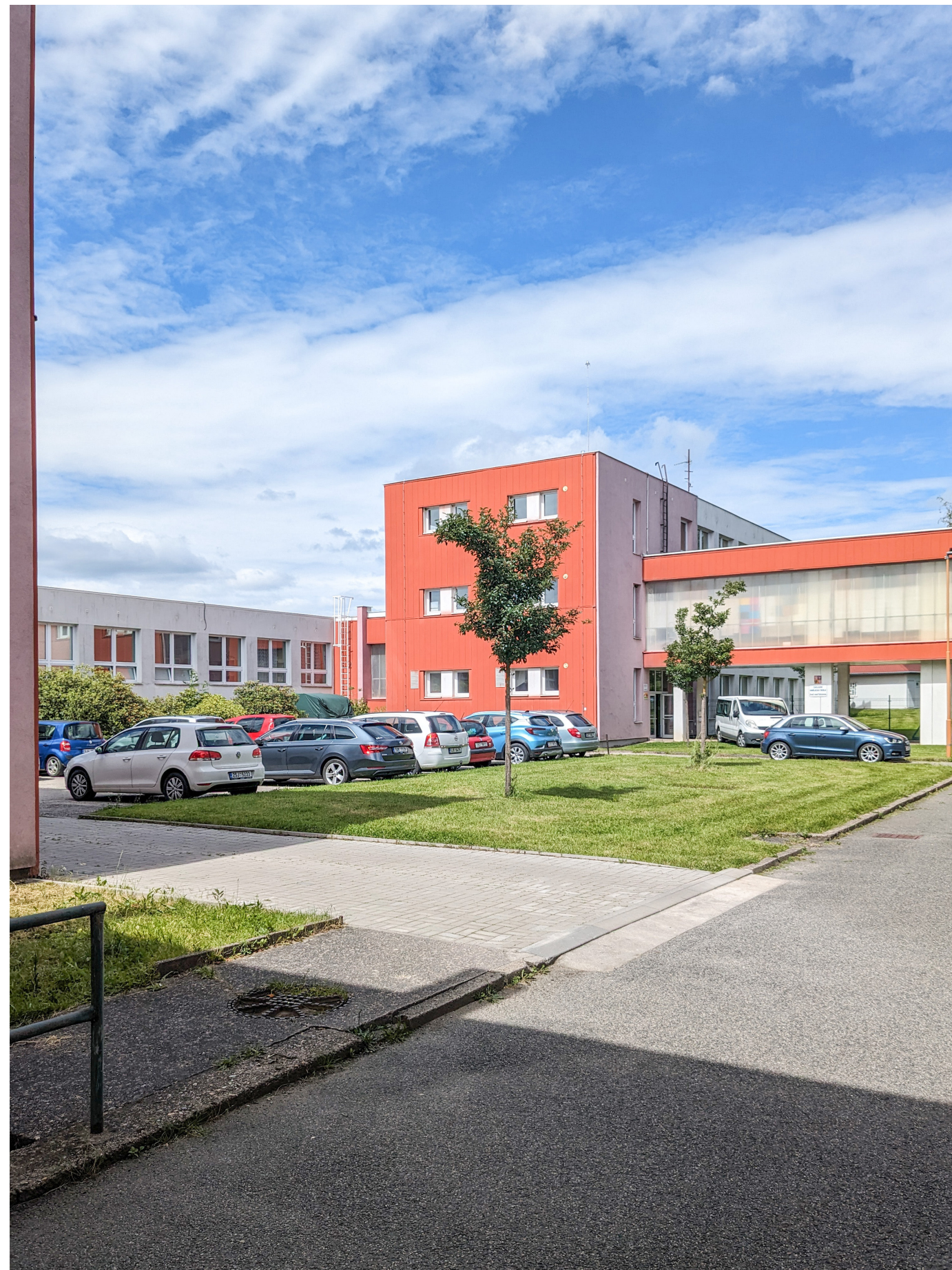
školní dvůr, pohled na ZUŠku
