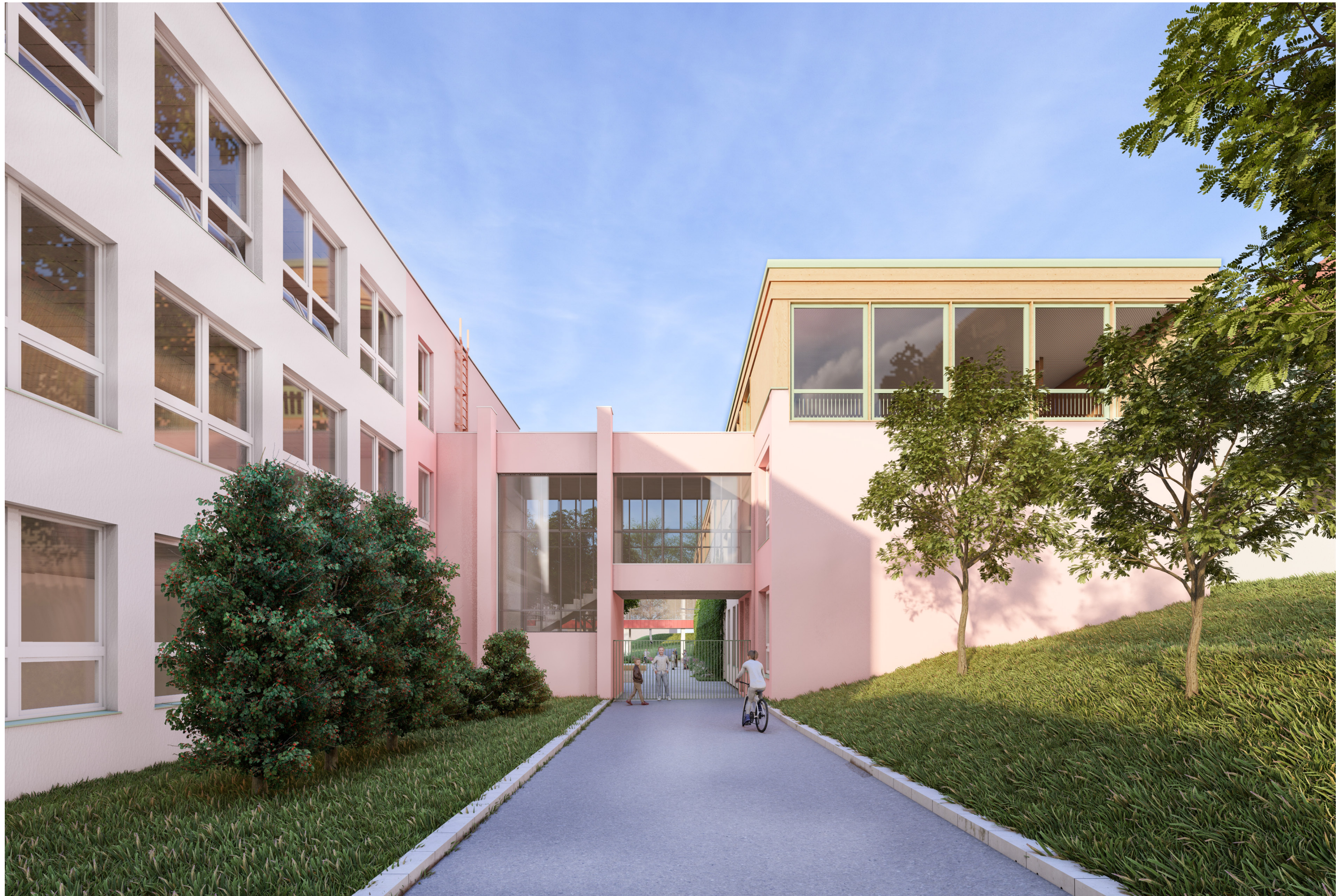
východní fasáda - vstup do dvoru
