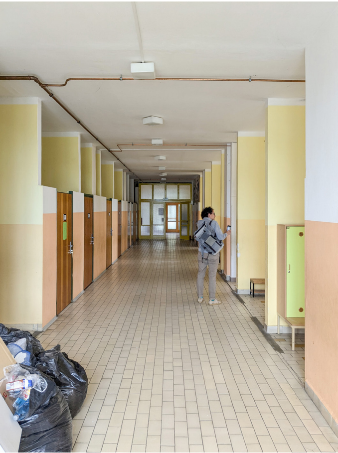
šatny I. stupně - hlavní chodba
