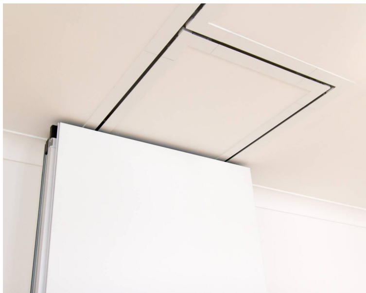
vodící kolejnice v poshledu
