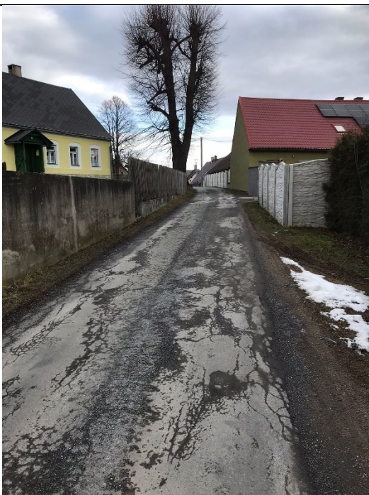
Průběh úseku A2 š.cca 3m
