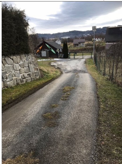
Průběh úseku C1 š.cca 3m
