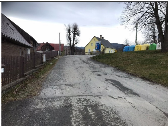
Začátek úseku B u čp.17
