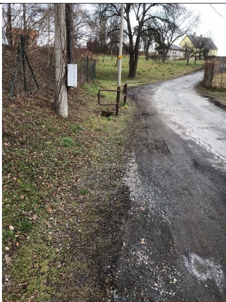
Řešení závady Z2 - doplnění šachty/vpustě C 250 dešťové kanalizace a krajnice s vodícím proužkem z žulových kostek 20bm
