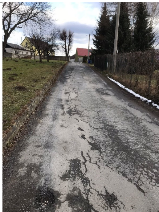
Průběh úseku A1 š.cca 4m
