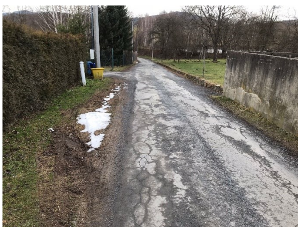
Řešení závady Z3 – rozšíření krajnice u čp.34
