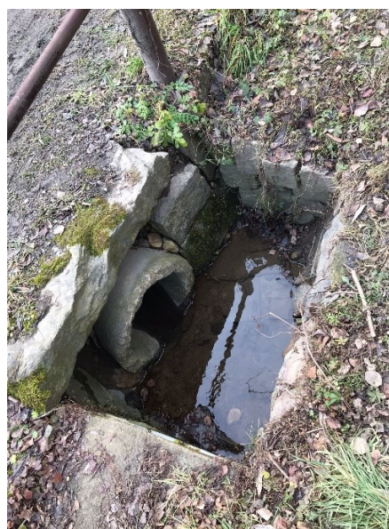
Závada Z2 – detail šachty
