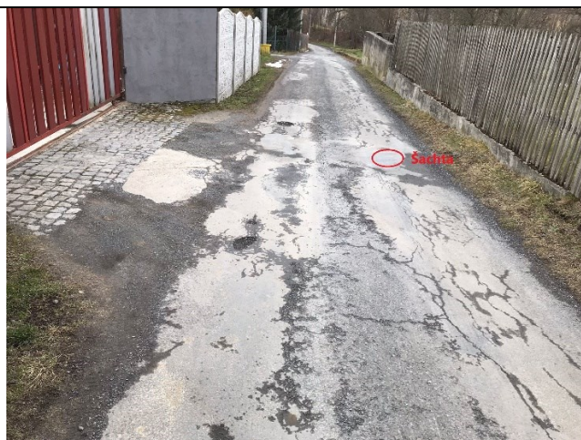
Řešení závady Z4 – výšková úprava šachty splaškové kanalizace VaKu
