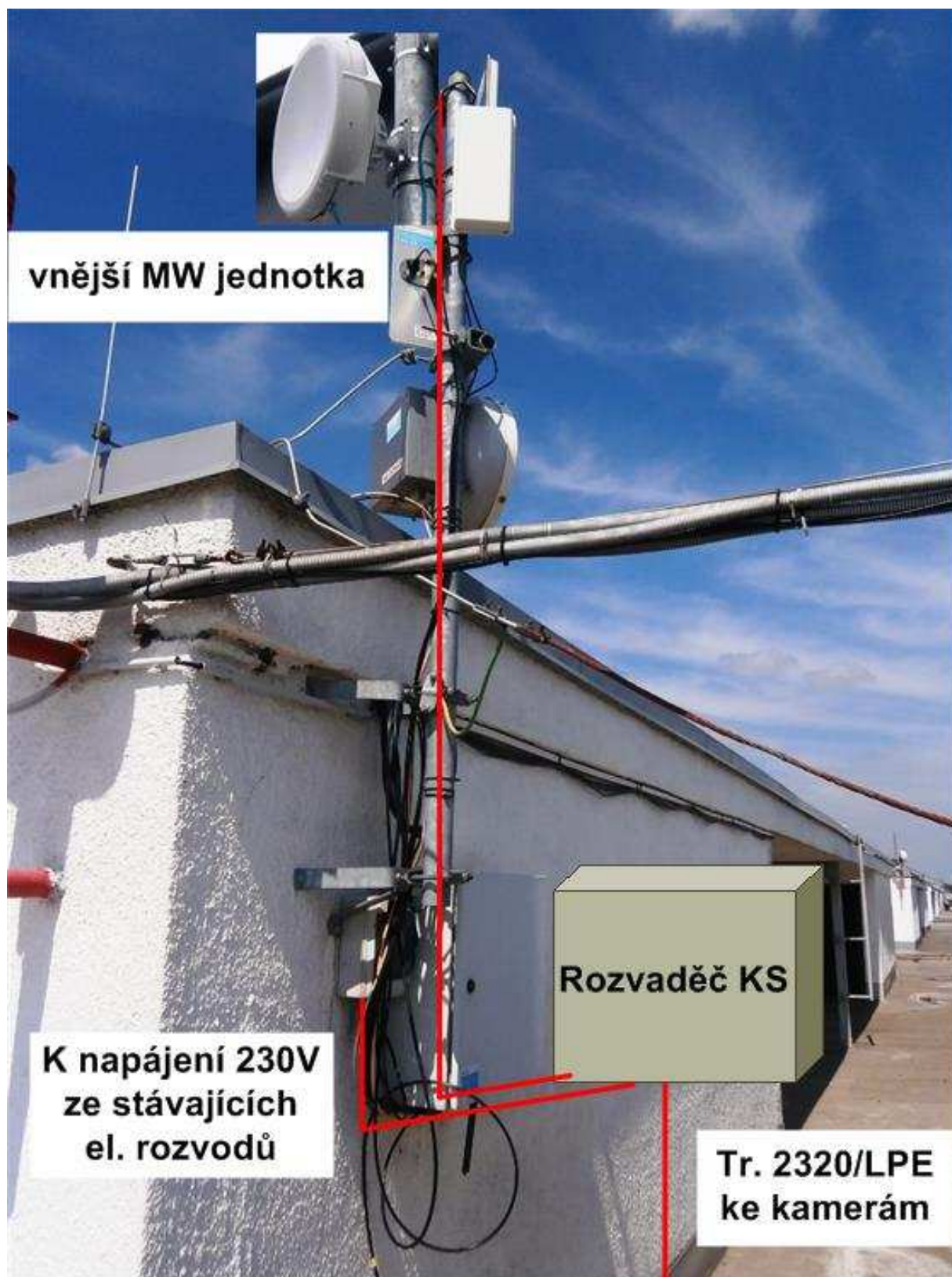
Obr. 2.16. Umístění rozvaděče KS a MW spoje.
