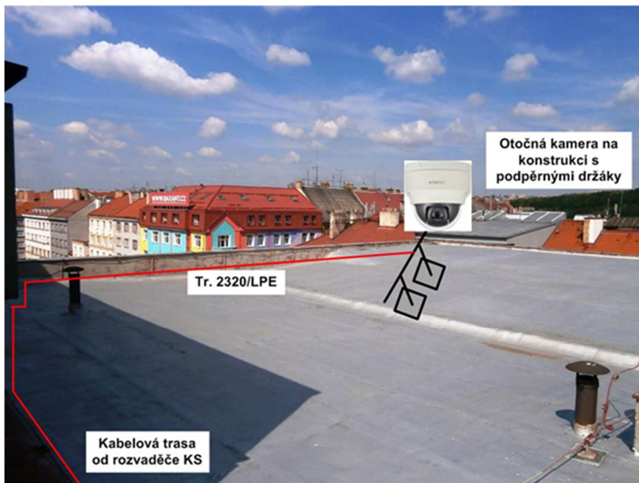
Obr. 2.7. Umístění otočné kamery na střeše (do ul. Drahobejllova).
