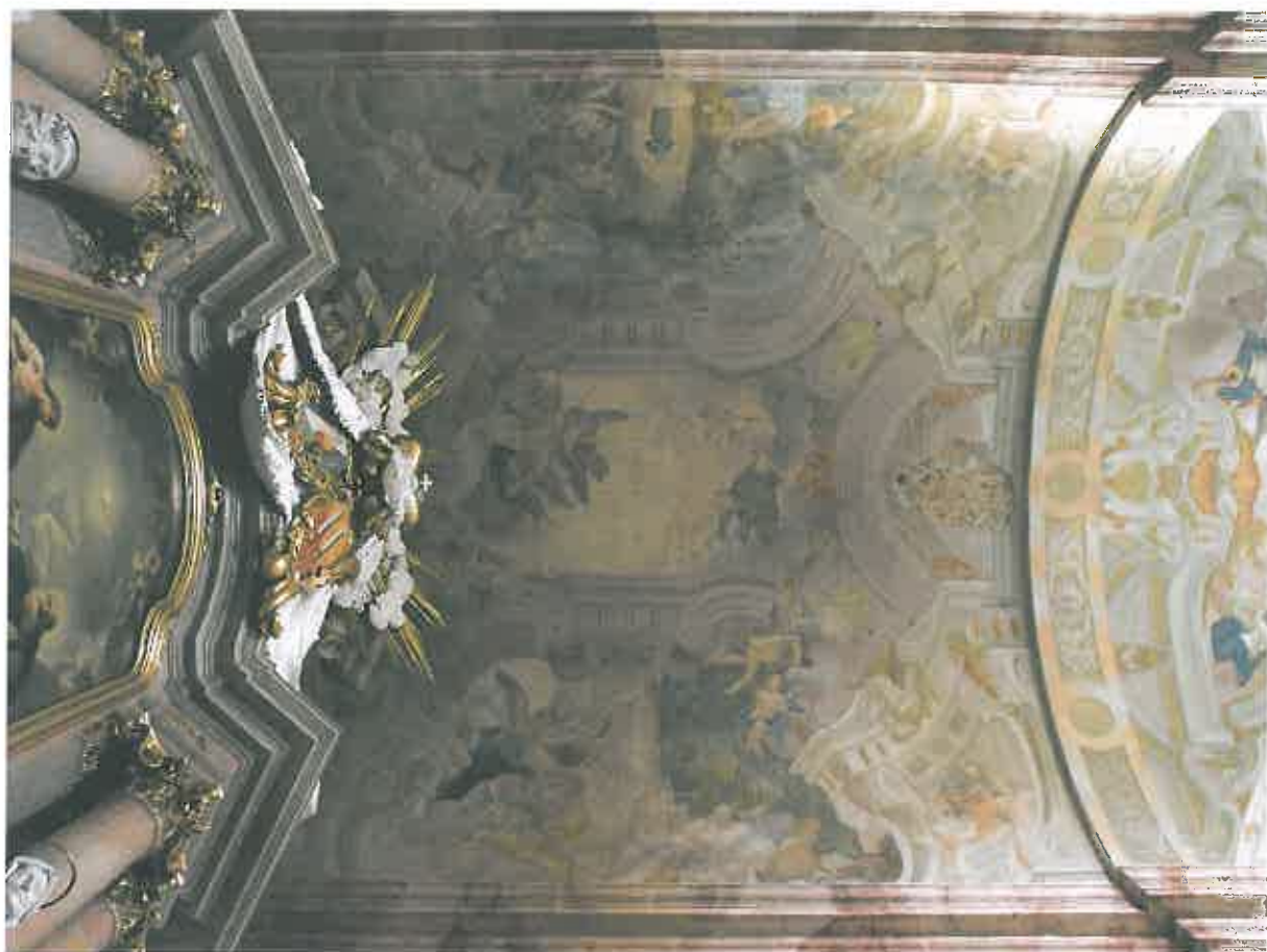
Celkový pohled na nástěnnou výmalbu před započítím prací z 11/2006 (po uvolnění omítkové kry) v presbytář a v lodi kostela Narození Panny Marie na Vranově u Brna
