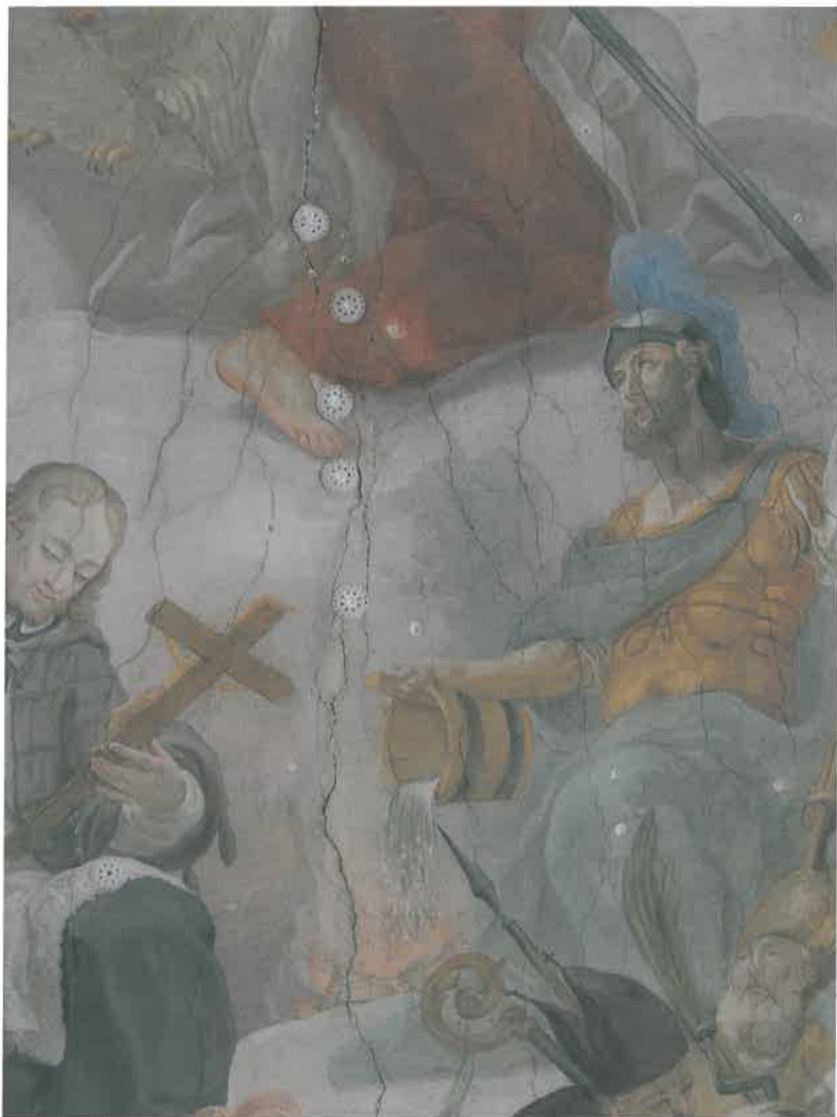
Část kompozice se sv. Janem Nepomuckým a sv. Floriánem v průběhu injecktáže meziomítkových dutin 08/2015.
