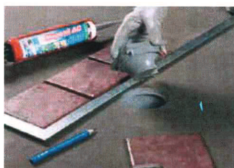
5. Mapesilem AC přilepte bodově na čtyřech místech nástavec na mřížku (s již umístěnou zápachovou uzavěrou). Je důležité, aby podstavec pod mřížku nebyl napevno slepen se silikonovým O-kroužkem, ale pouze na čtyřech místech silikonem, aby všechna voda, která pronikne mezi dlažbu a hydroizolační vrstvu směřovala do vpusti a nehromadila se v jejím okolí
