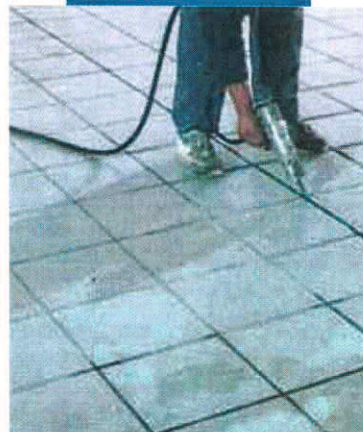
Těsnění spáry Mapesilem AC v keramické dlažbě
