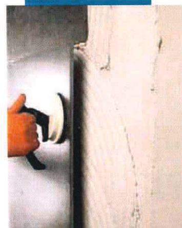
Pokládka keramické dlažby velkého formátu do Elastorapidu v exteriéru na podklad z betonu
