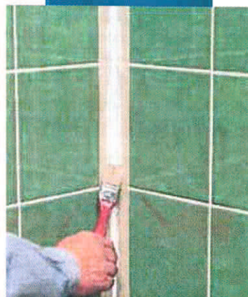
Vyhlazení povrchu spáry saponátovým roztokem a štětcem
