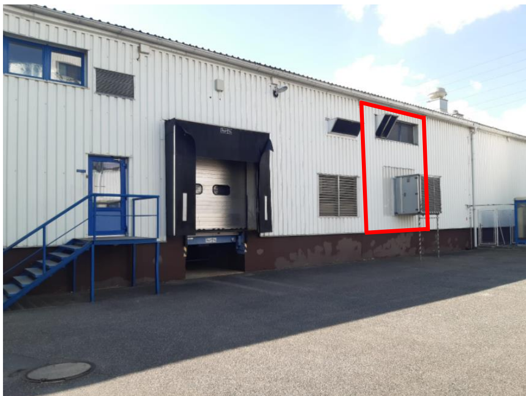
Obrázek 3 - pohled na rampu pro stěhování technologie u kompresorovny 2 (max. zatížení rampy je 6t)
