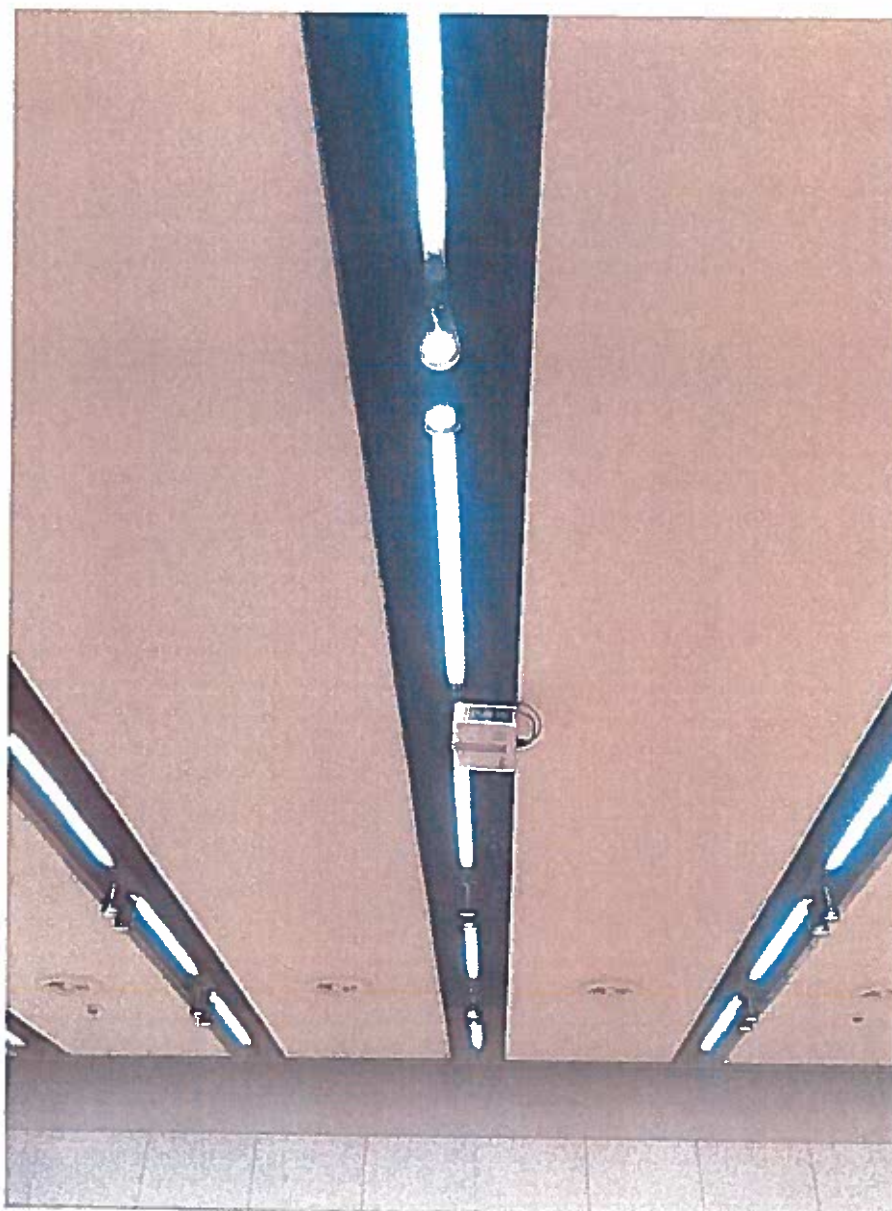
Obr. 11 – Detail svítidel a pohledu s možností prostupu pro umístění kotvení projektorů.
