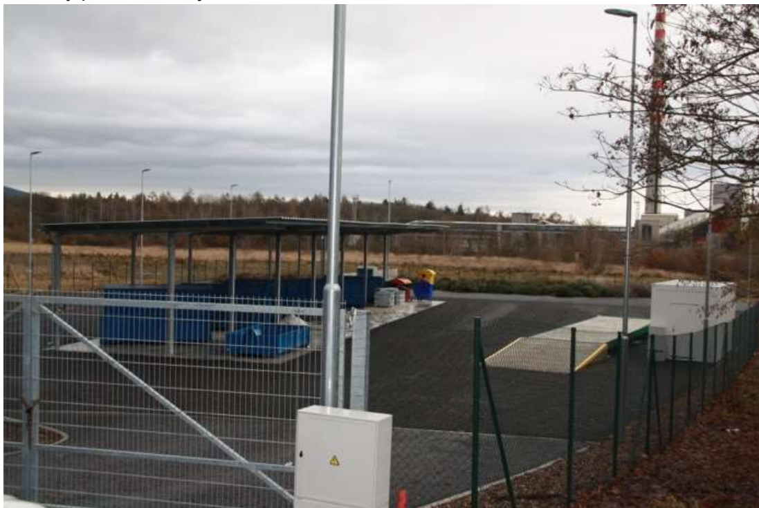
Celkový pohled na objekt
