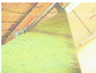
Biologické znečištění příčniku (řasy)
