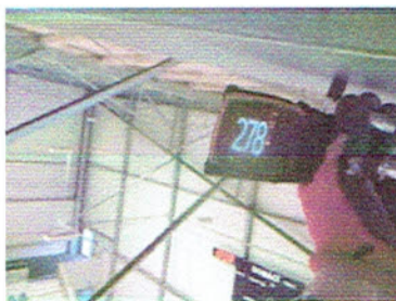
Kontrola DFT - strop
