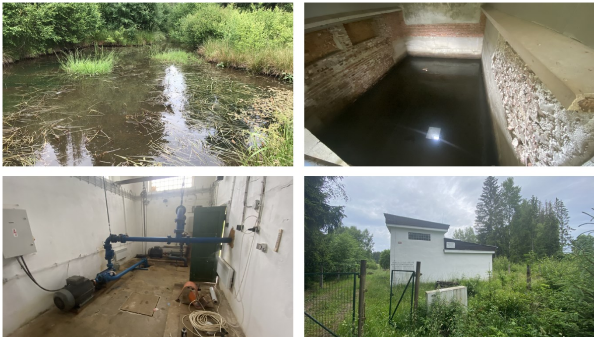
Obrázek 7. Fotografie jímání povrchové vody; místo odběru povrchové vody z Kozího potoka (vlevo nahoře), jedna z akumulacích nádrží v budově jímání (vpravo nahoře), technologie čerpání v budově (vlevo dole) a celkový pohled na budovu jímání od příjezdové cesty (vpravo dole)
