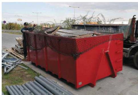
Odpadový materiál ukládaný do kontejnerů musí být vždy zajištěn sítí proti odnesení větrem.
