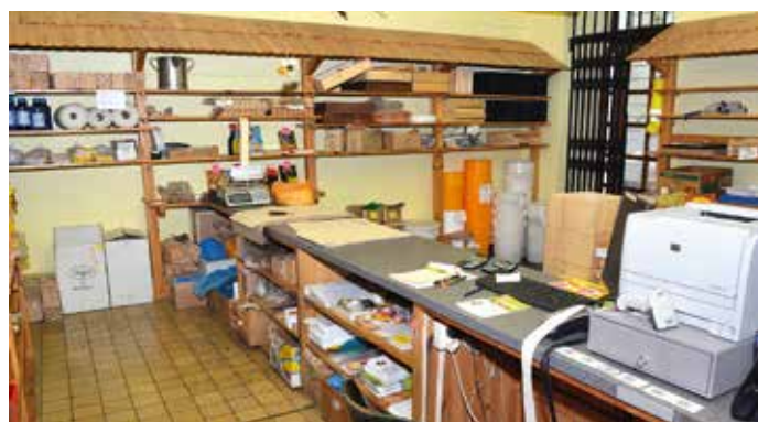
Průběh opravy interiéru prodejny Včelpe. Původní stav ke dni 14. 2. 2019
