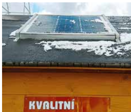
Elektřinu pro automat obstarává fotovoltaický panel
