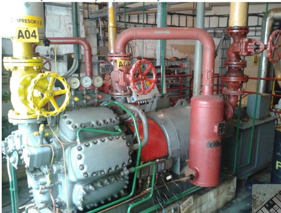
Stávající stav soustrojí č. 2, štítek stávajícího motoru
