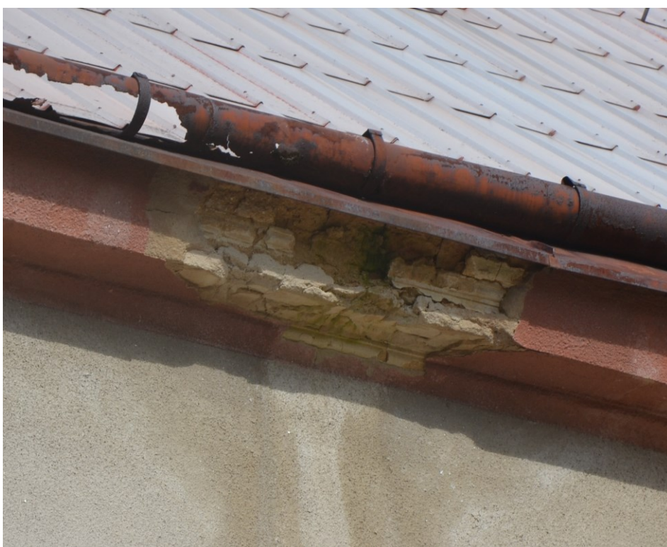
Obr 7: Porucha římsoy.
