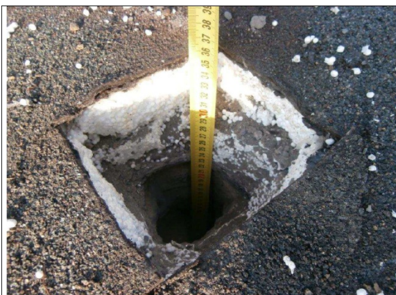
Obr. č. 3: Pohled do kopané sondy - objekt č.1;
