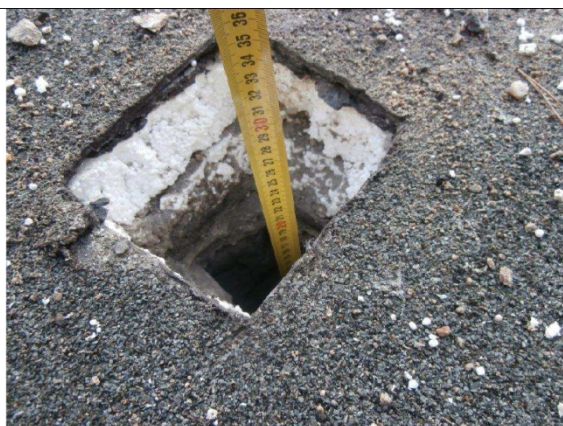
Obr. č. 4: Pohled do kopané sondy – objekt č.2
