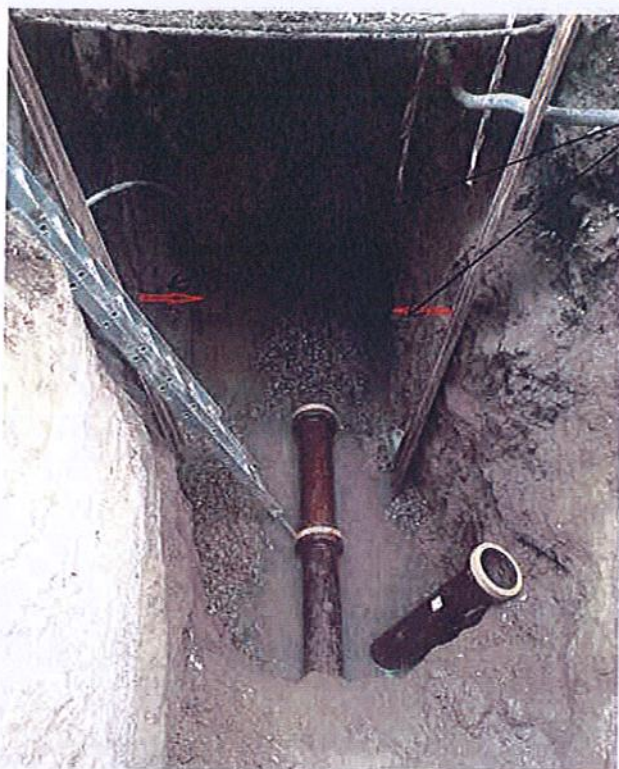
Obr. č.5 – Kanalizační přípojka KP92, ukončení přípojky před objektem
