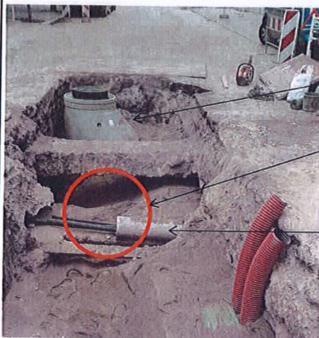
Obr. č.1 – Propojení na stáv. kanalizaci do ul. Přadlácká, posun šachty Š21 kolize se stáv. kabely
