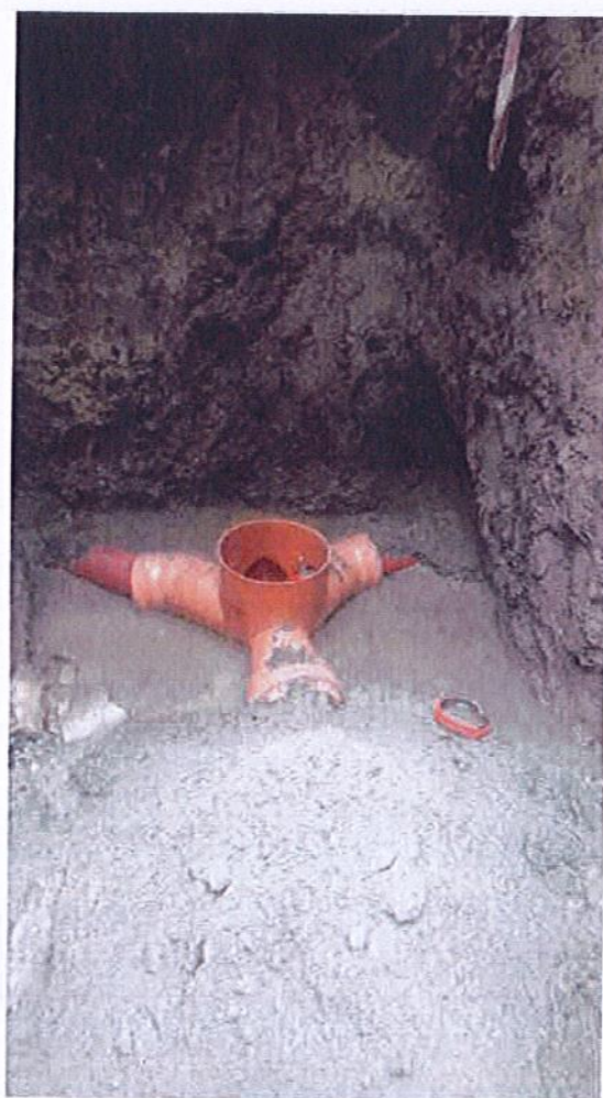
Obr. č.6 – Kanalizační přípojka KP92 – provizorní šachta, napojení přípojkových větví
