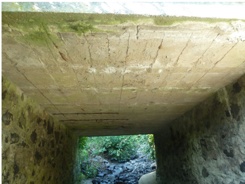
Podhled nosné konstrukce
