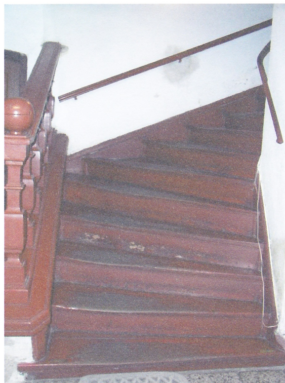
Současný stav schodiště, celkové pohledy
