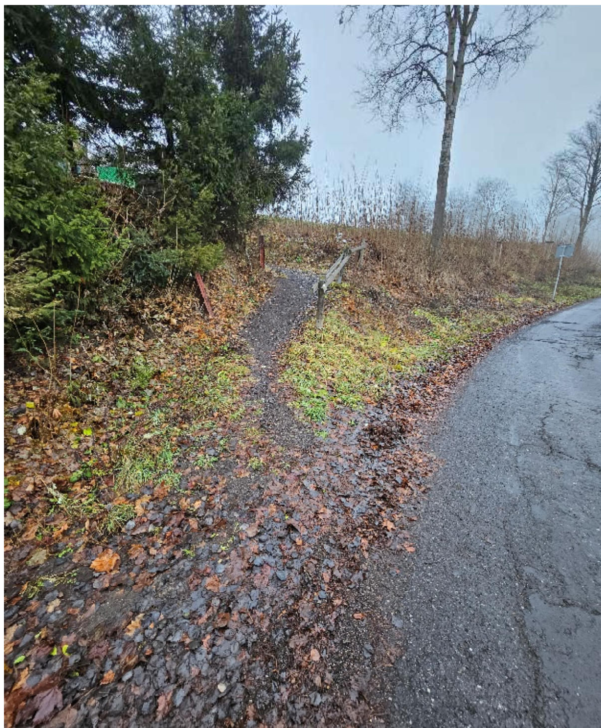
Foto současného stavu:
