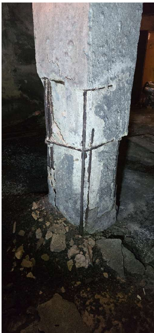
Nosné sloupy se zcela obnaženou a zdegradovanou nosnou výztuží
