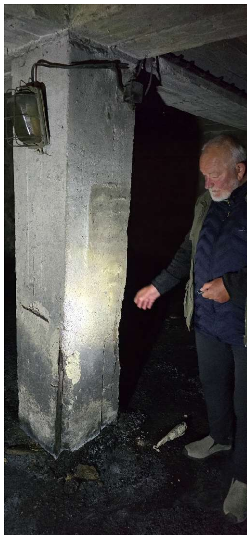
Nosné sloupy se zcela obnaženou a zdegradovanou nosnou výztuží
