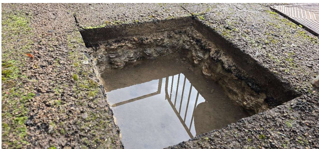
Sonda ve vozovce nad uhelnou – živice+spádové vrstvy+ŽB deska (hydroizolace nezjištěna)
