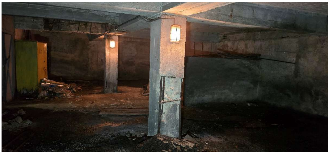
Pohled do bývalé uhelny
