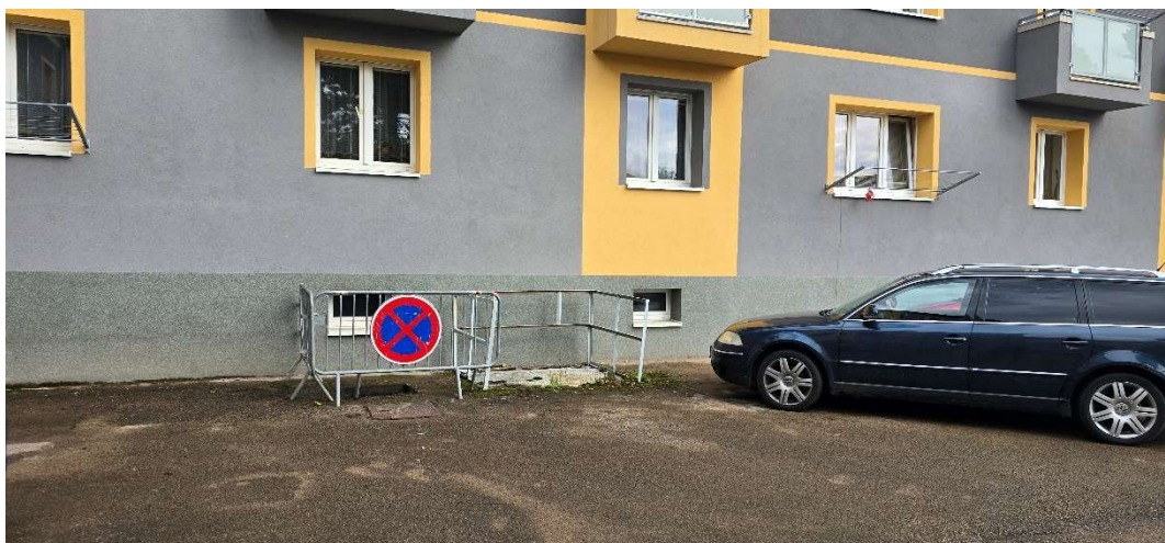
Zpevněná plocha nad uhelnou – stávající stav
