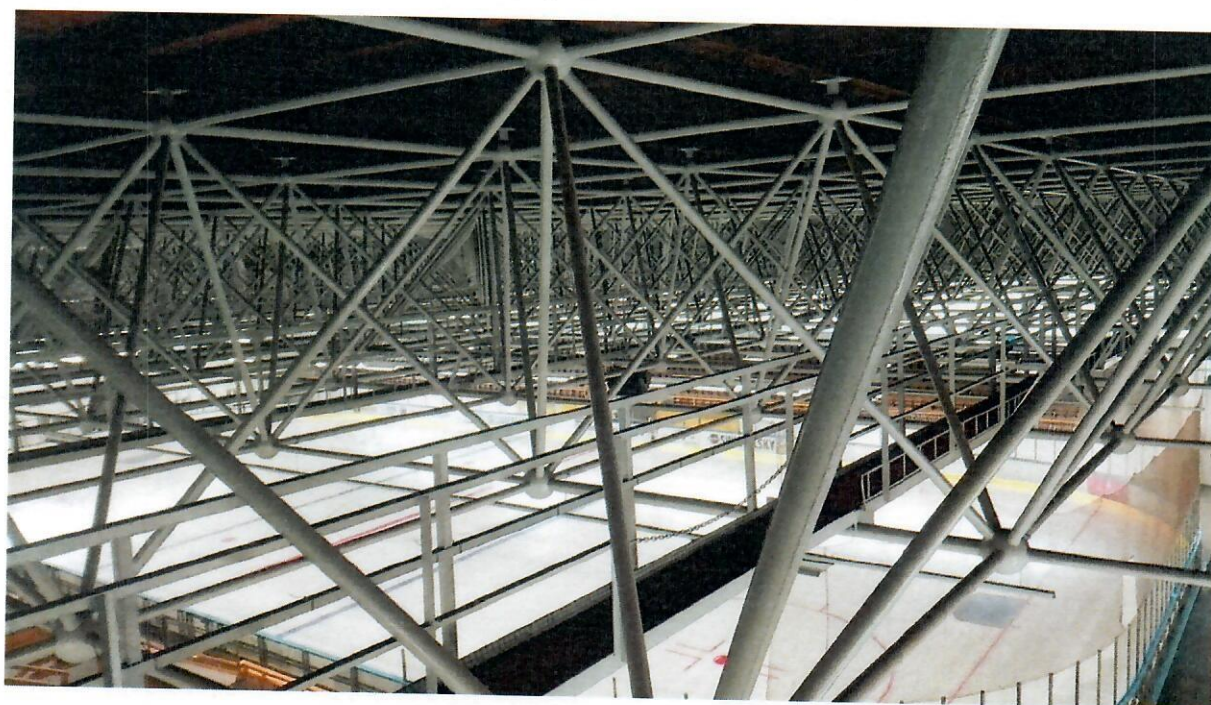
Obr. č. 2: Pohled do konstrukce z revizní lávky v r. 2019. Patrný je celkově lepší stav nátěrů po opravách doporučených v r. 2013 (foto z prohlídky 14. 8. 2019).
