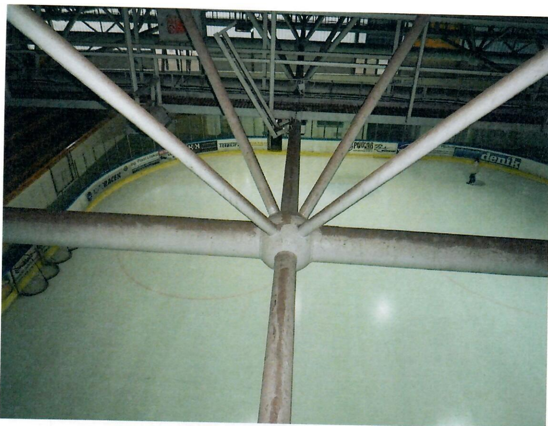
Obr. č. 1: Pohled do konstrukce z revizní lávky v r. 2013.
