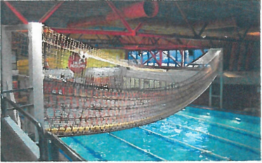
Tunel ze sítí ve tvaru V (prostor plaveckého bazénu), délka 21 m
