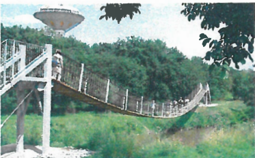
Most s dřevěnou lávkou, délka 54 m
