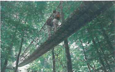
Most s dřevěnou lávkou, délka 40 m
