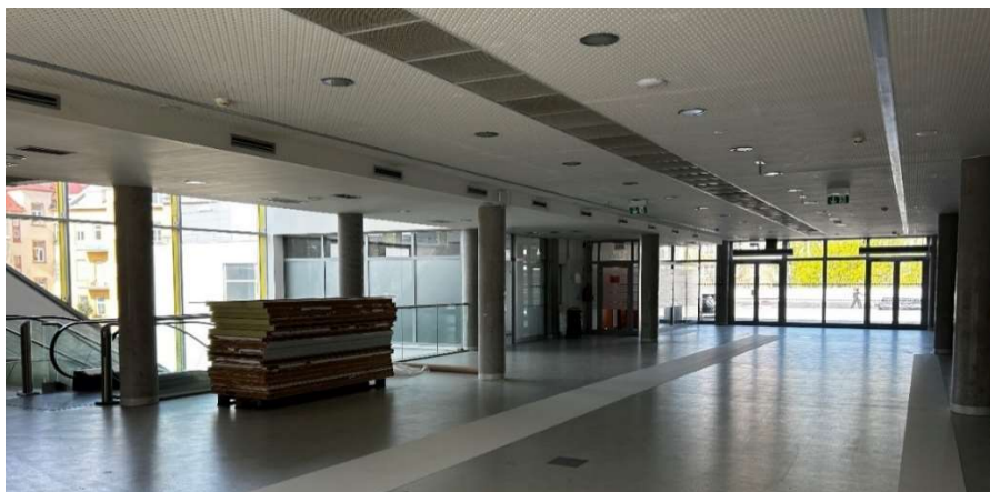
Obrázek 2 – Fotodokumentace z prohlídky konstrukce 2.NP
