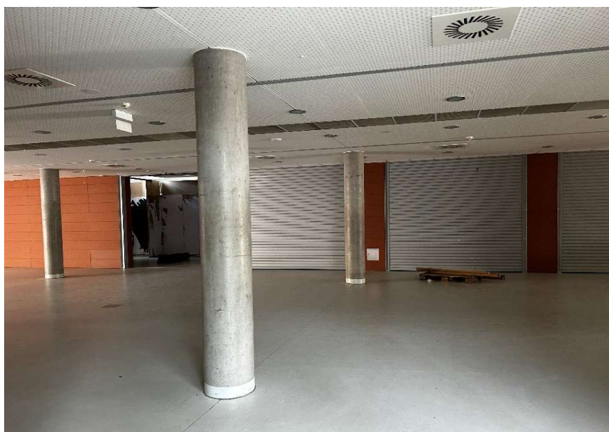
Obrázek 3 – Fotodokumentace z prohlídky 1.NP – přítěžované sloupy
