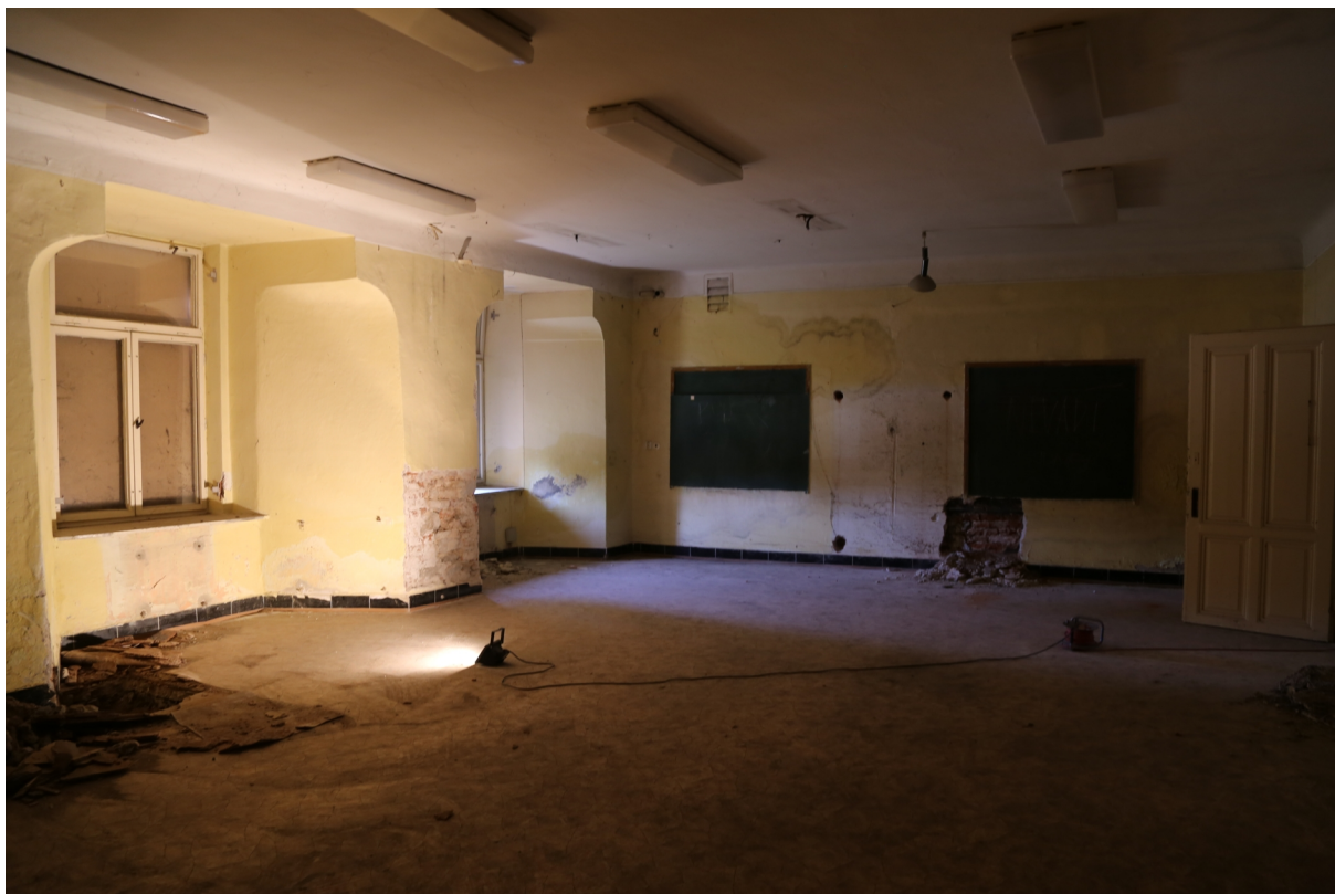
I.č. 03728-2017 Znojmo, někdejší klášter v Louce. Západní křídlo středověké kvadratury - Stará škola. Přízemí, místnost 1.04 - pohled na severní stěnu.
