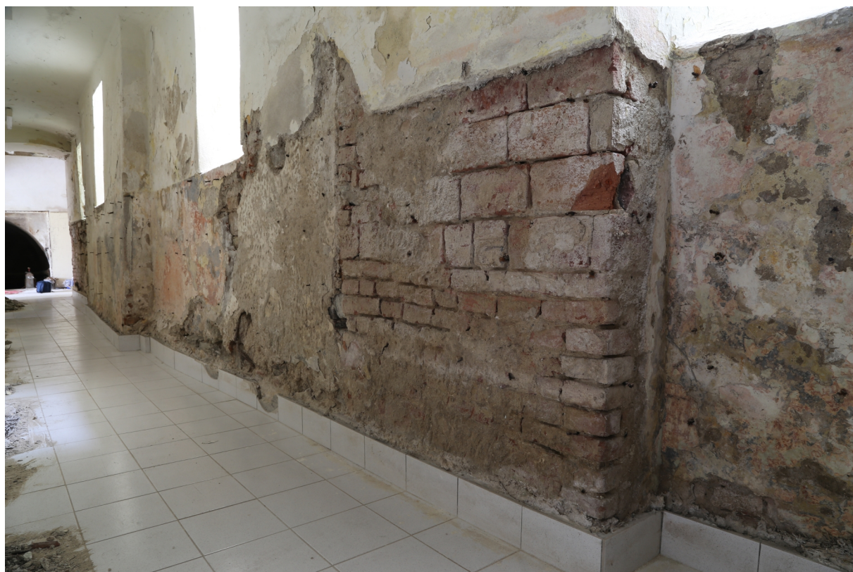
I.č. 03833-2017 Znojmo, někdejší klášter v Louce. Západní křídlo středověké kvadratury - Stará škola. Přízemí, chodba1.03 - odkrytá střední část východní stěny.
