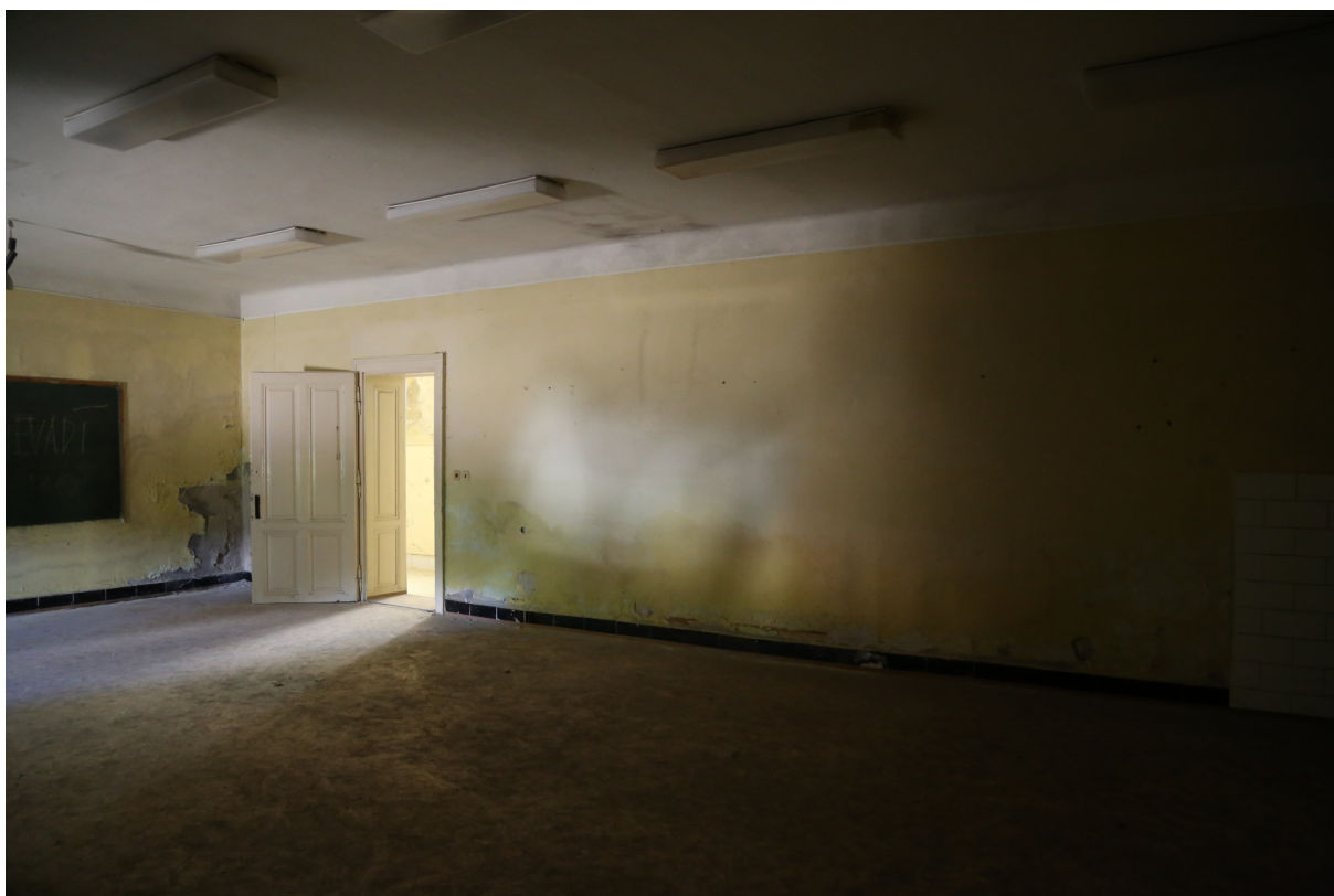
I.č. 03396-2017 Znojmo, někdejší klášter v Louce. Západní křídlo středověké kvadratury - Stará škola. Přízemí, místnost 1.04 - pohled na východní stěnu.
