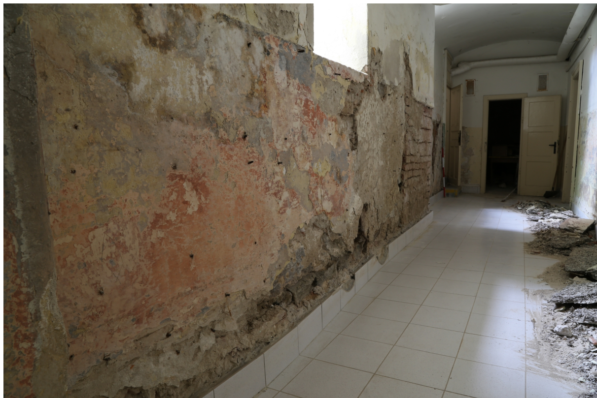
I.č. 03828-2017 Znojmo, někdejší klášter v Louce. Západní křídlo středověké kvadratury - Stará škola. Přízemí, chodba1.03 - odkrytá střední část východní stěny.
