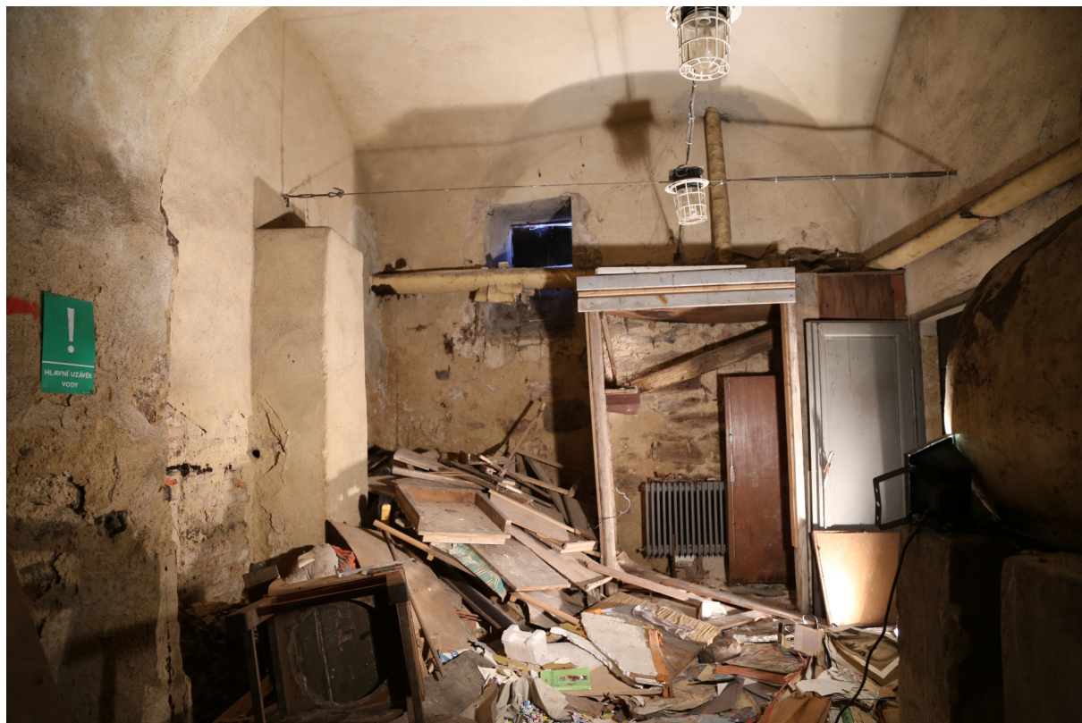
I.č. 03522-2017 Znojmo, někdejší klášter v Louce. Západní křídlo středověké kvadratury - Stará škola. Suterén, místnost 0.05 - pohled na západní čelní stěnu.
