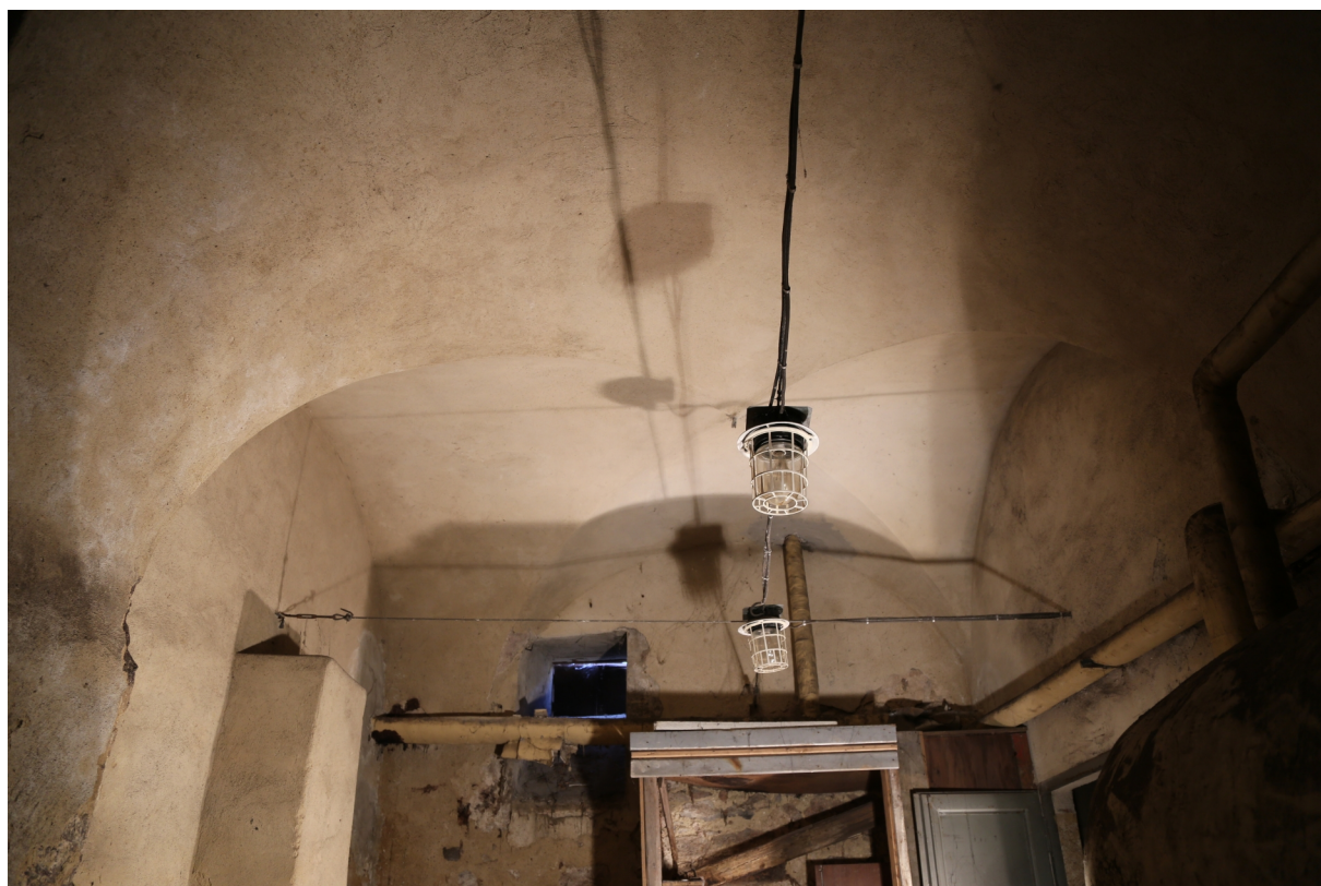
I.č. 03523-2017 Znojmo, někdejší klášter v Louce. Západní křídlo středověké kvadratury - Stará škola. Suterén, místnost 0.05 - pohled na západní čelní stěnu.
