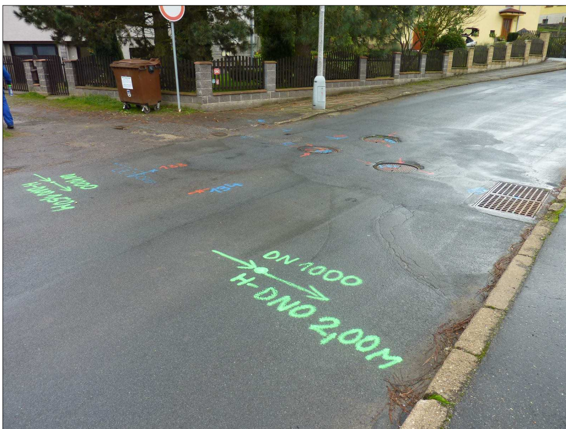
Měření hloubky uložení zatrubněné Lejšovky přes komunikaci ul. Dobiášova.
