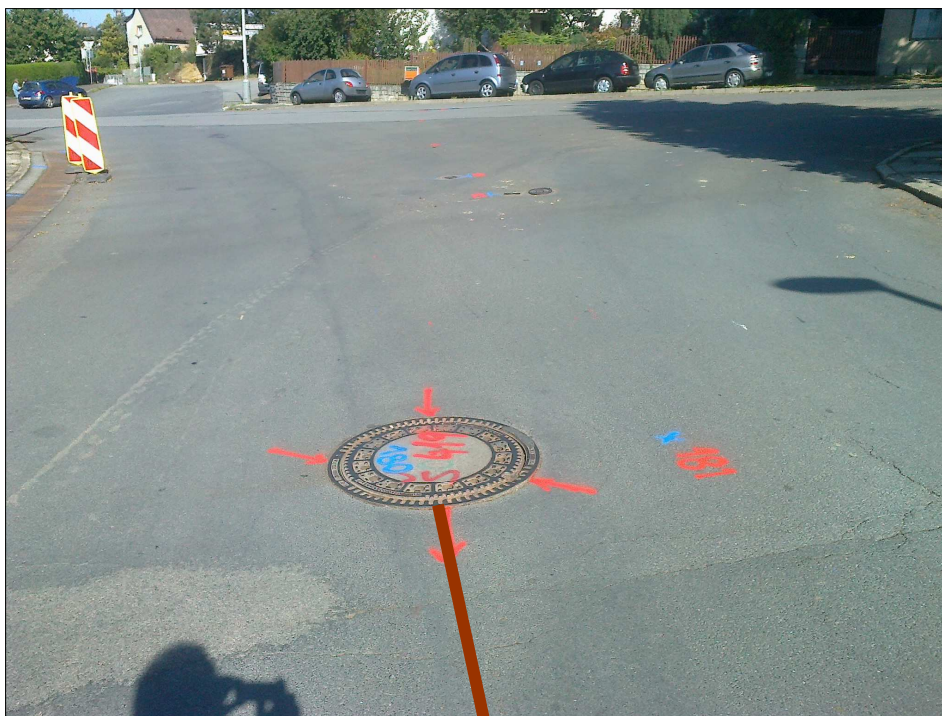
Měření hloubky uložení zatrubněné Lejšovky přes komunikaci ul. Dobiášova.
