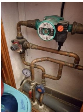
Fotografie napojení pro podlahové vytápění
