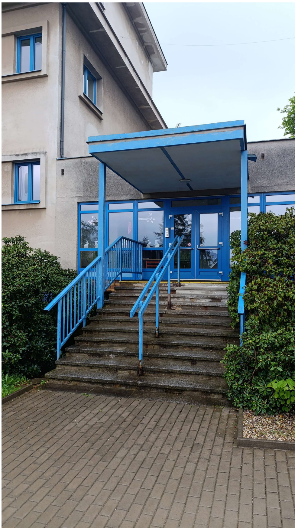
Fotodokumentace – hlavní schodiště:
