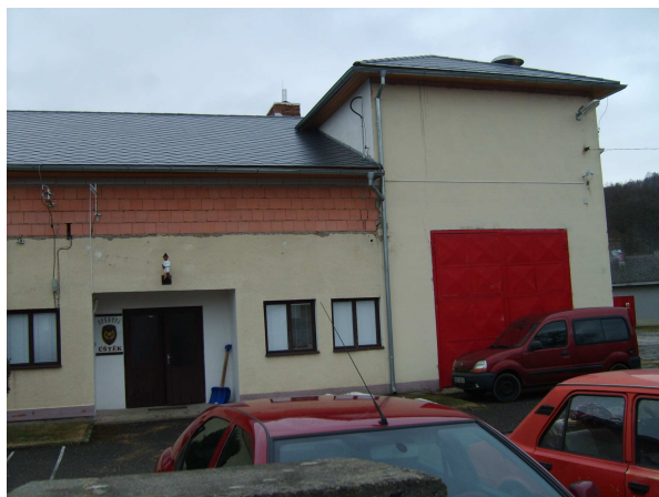
obrázek 4 Fotodokumentace stavební části
