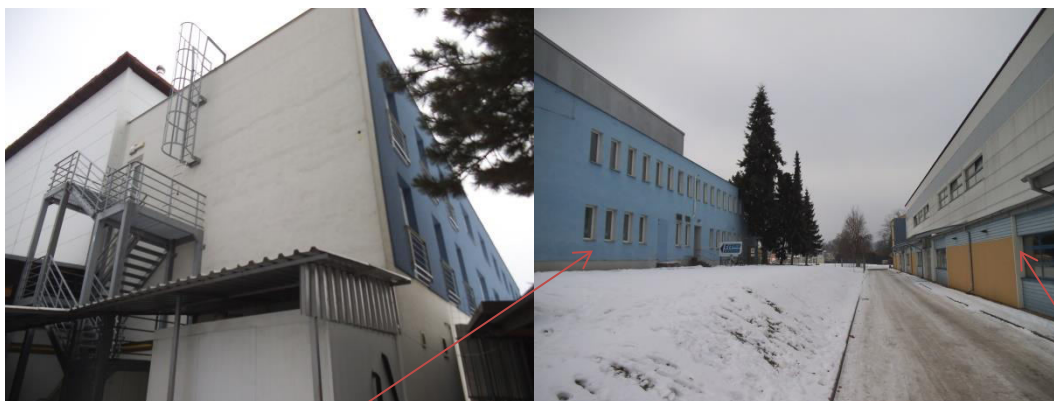
foto č. 3 a 4 – vlevo budova ubytovny; vpravo odstupová vzdálenost mezi zimním stadionem a plaveckým bazénem
