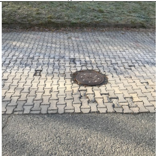
Detail šachty splaškové kanalizace
