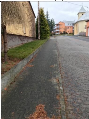
Detail chodníku v úseku A
