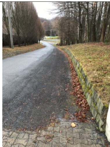
Krajnice úseku B s trasou dešťové kanalizace
