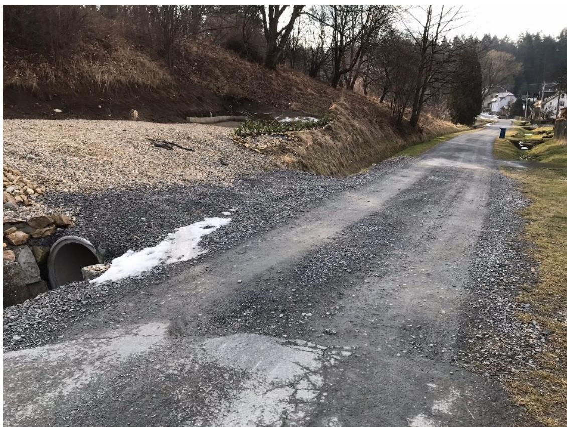
Provizorní zprovoznění poškozeného úseku po povodni 9-2024
