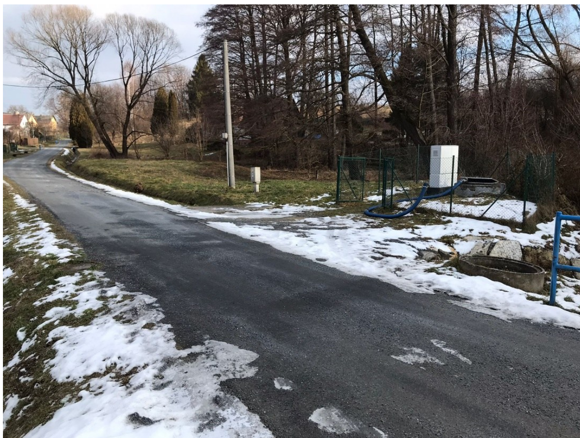
Čerpací stanice splaškové kanalizace (doplnění zpevněné plochy)
