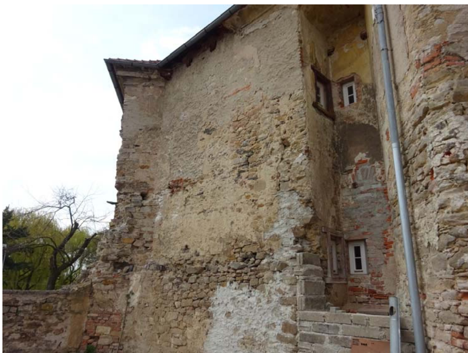
obrázek č.4 Pohled na jižní stěnu
