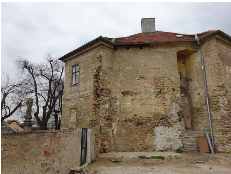
obrázek č.2 Pohled na jižní stěnu
