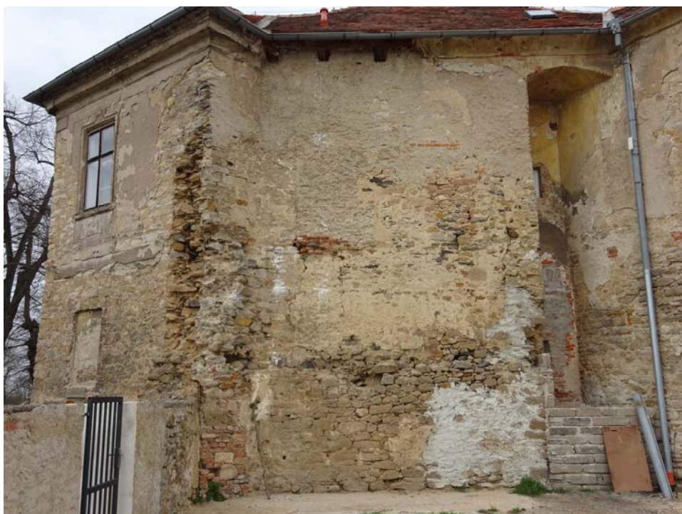
obrázek č.3 Pohled na jižní stěnu
