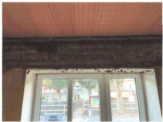
ZMĚNA 4 – nadezdívky, vyrovnávky degradovaného stropního zdiva a doplnění oc. válcovaného nosníku v místě vybouraného průvlaku (§ 222 odst. 5 a 6 ZZVZ)
