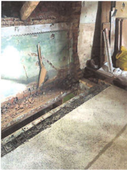
ZMĚNA 4 – nadezdívky, vyrovnávky degradovaného stropního zdiva a doplnění oc. válcovaného nosníku v místě vybouraného průvlaku (§ 222 odst. 5 a 6 ZZVZ)
