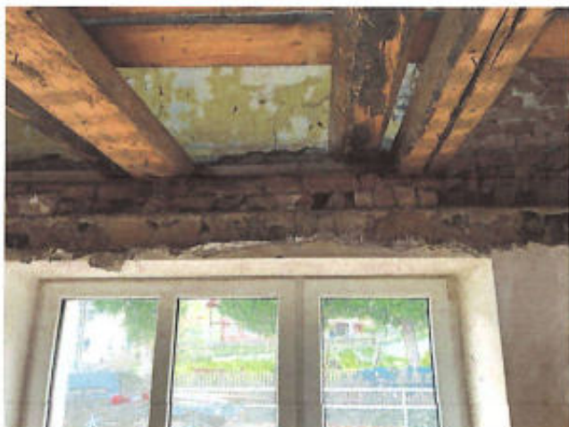
ZMĚNA 5 – přízdívky obvodového zdiva a doplnění ztužujícího věnce na štitové stěny v 2.NP podkroví (§ 222 odst. 5 ZZVZ)
