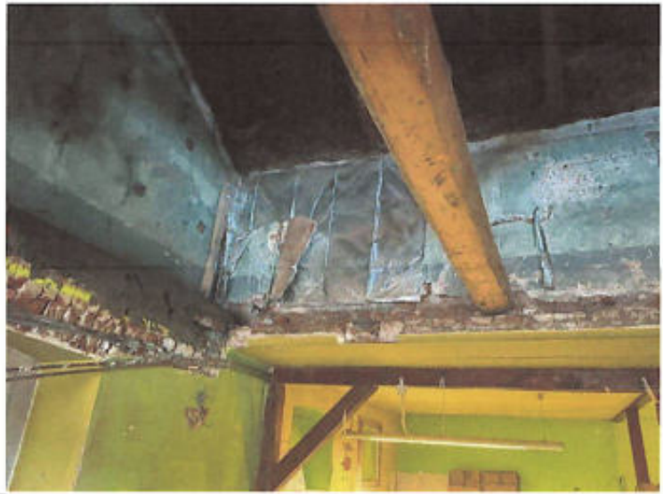
ZMĚNA 4 – nadezdívky, vyrovnávky degradovaného stropního zdiva a doplnění oc. válcovaného nosníku v místě vybouraného průvlaku (§ 222 odst. 5 a 6 ZZVZ)
