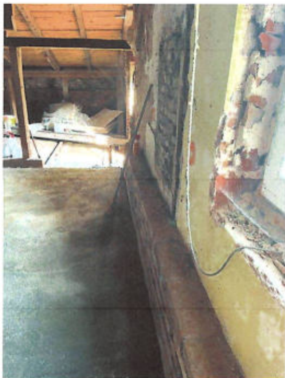
ZMĚNA 5 – přízdívky obvodového zdiva a doplnění ztužujícího věnce na štitové stěny v 2.NP podkroví (§ 222 odst. 5 ZZVZ)
