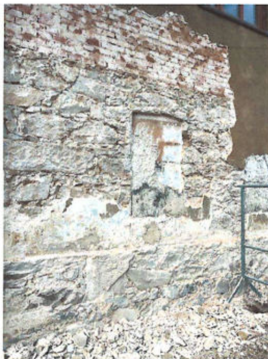
ZMĚNA 5 – přízdívky obvodového zdiva a doplnění ztužujícího věnce na štitové stěny v 2.NP podkroví (§ 222 odst. 5 ZZVZ)
