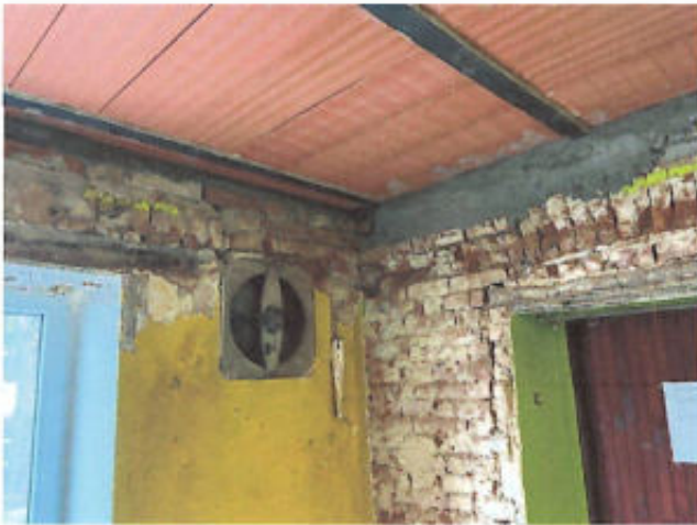
ZMĚNA 4 – nadezdívky, vyrovnávky degradovaného stropního zdiva a doplnění oc. válcovaného nosníku v místě vybouraného průvlaku (§ 222 odst. 5 a 6 ZZVZ)
