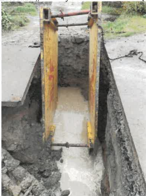
Obr. 1 Snímek zastižených tekutých písků v rýze.
