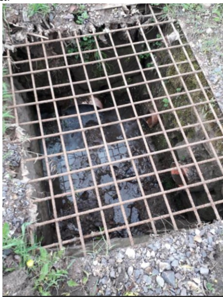
Stávající horská vpust' HV2
