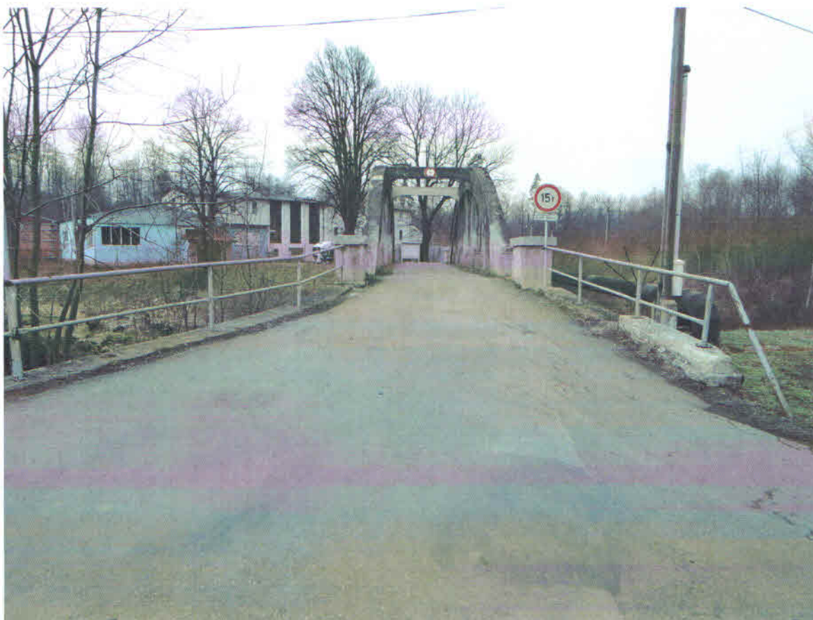
Pohled na most ve směru staničení od sil. I/44
