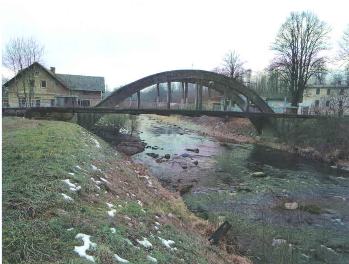
Pohled na most zprava ( povodní strany )
