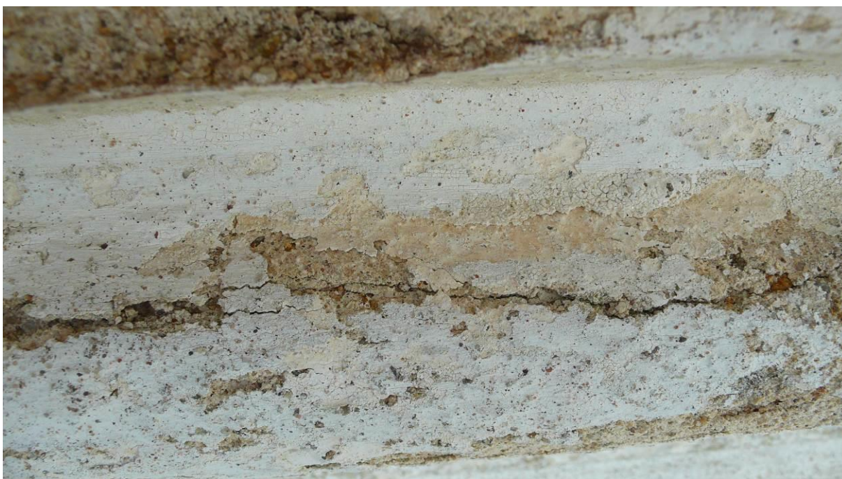
Severozápadní strana 54 Prosvítající červená vrstva
