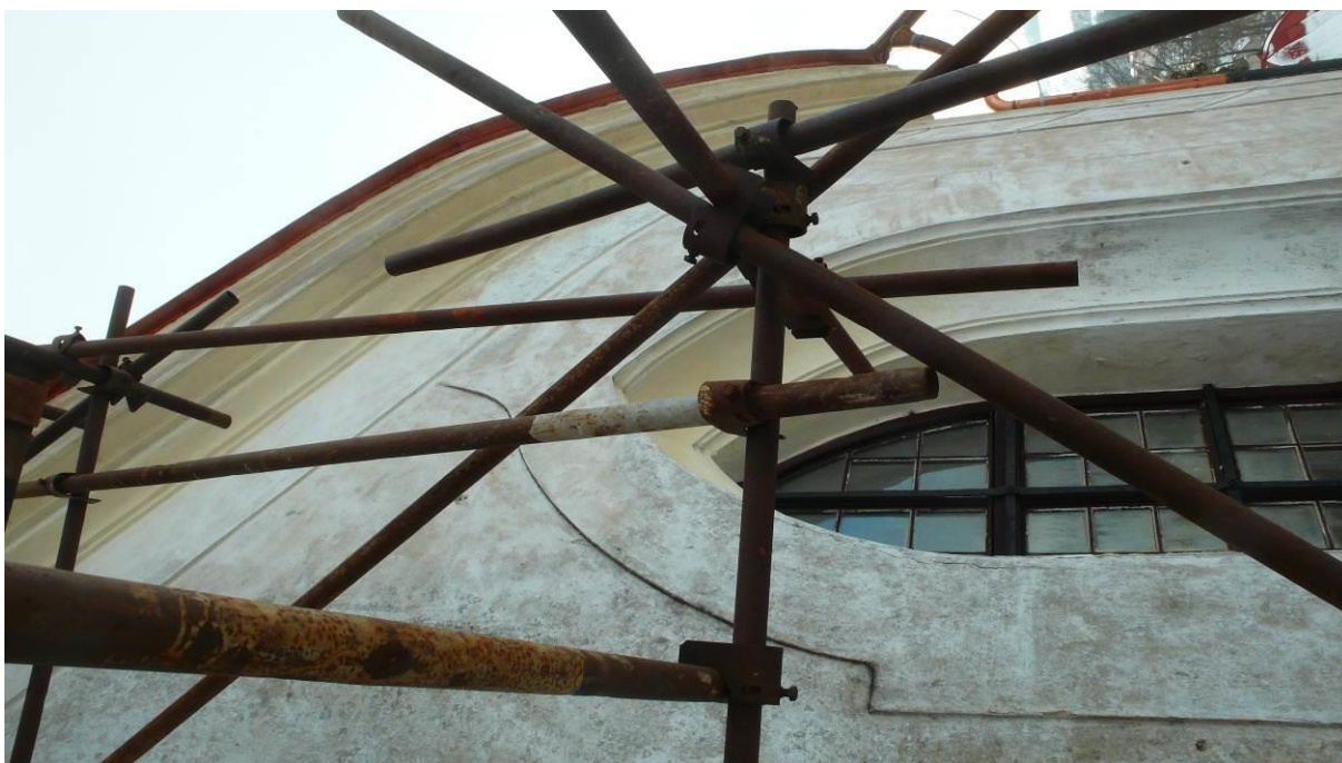
Severovýchodní strana 46 Souvrství omítek
