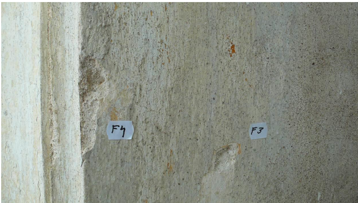
Severovýchodní strana 45 Prosvítající okrová vrstva
