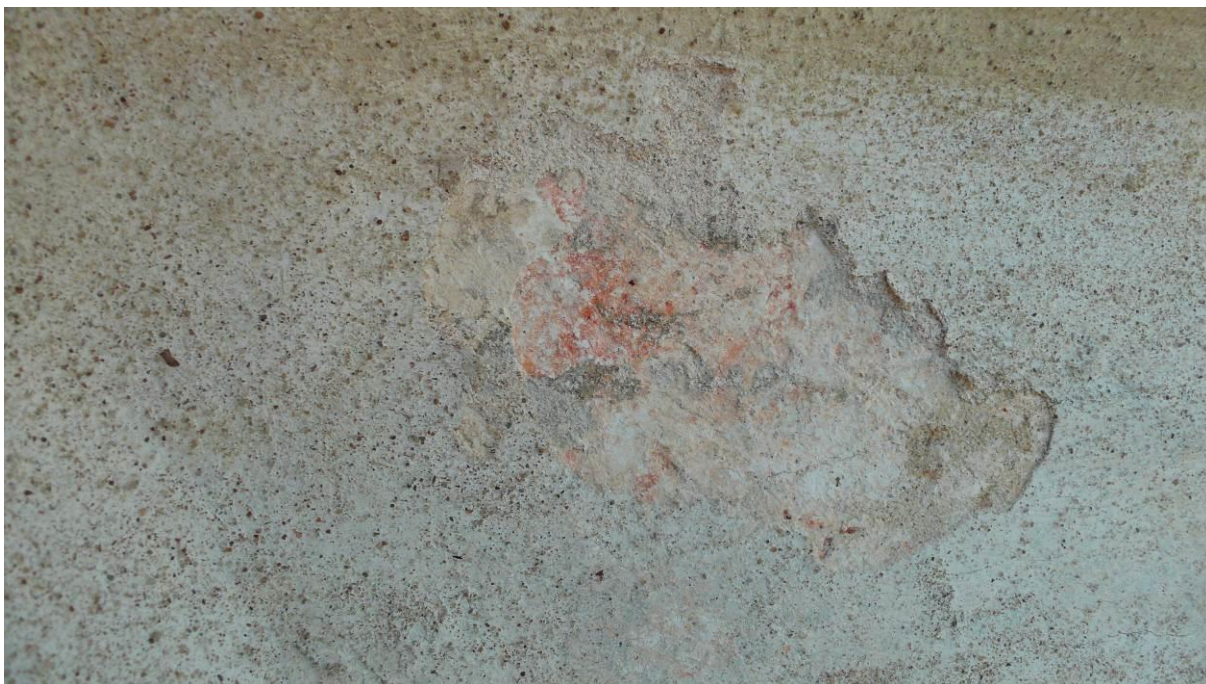
Severozápadní strana 61 Prosvítající červená vrstva
