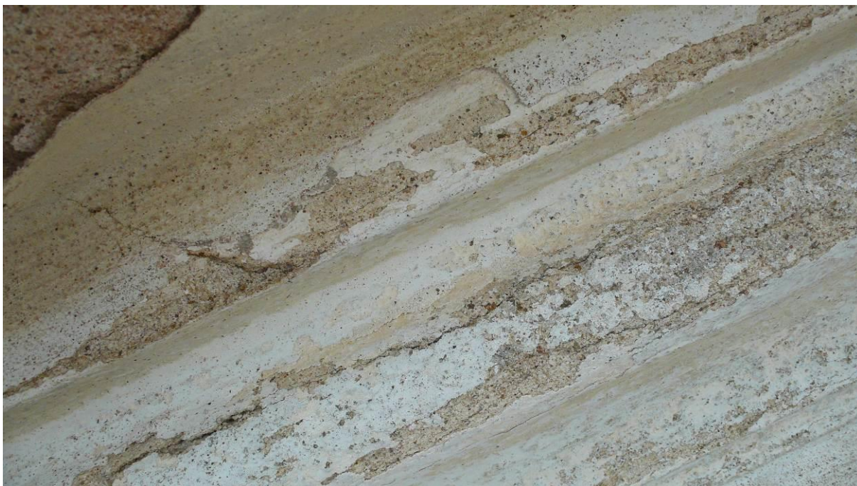
Severozápadní strana 53 Prosvítající červená vrstva
