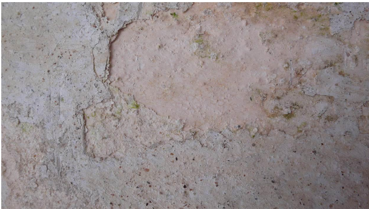
Jihozápadní strana 11 Vrchol stezky bosáže ve vnitřním prolomení fasády Prosvítající červená vrstva
