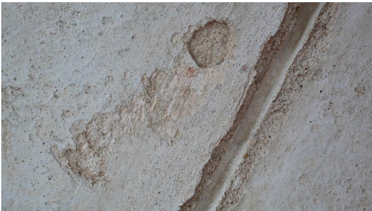
Jihozápadní strana 17 Vrchol stezky bosáže ve vnitřním prolomení fasády Prosvítající červená vrstva
