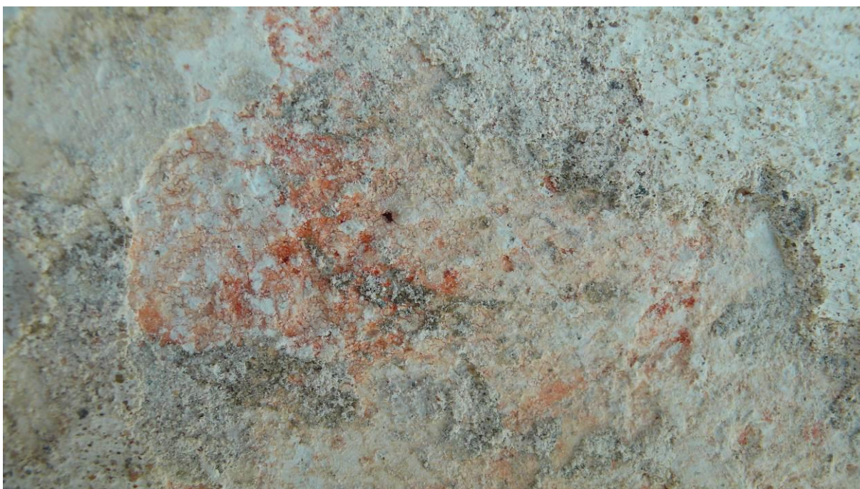
Severozápadní strana 63 Prosvítající červená vrstva
