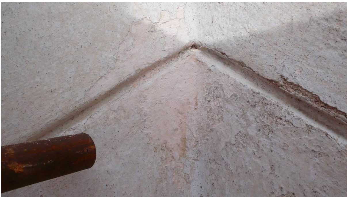
Jihozápadní strana 13 Vrchol stezky bosáže ve vnitřním prolomení fasády Prosvítající červená vrstva
