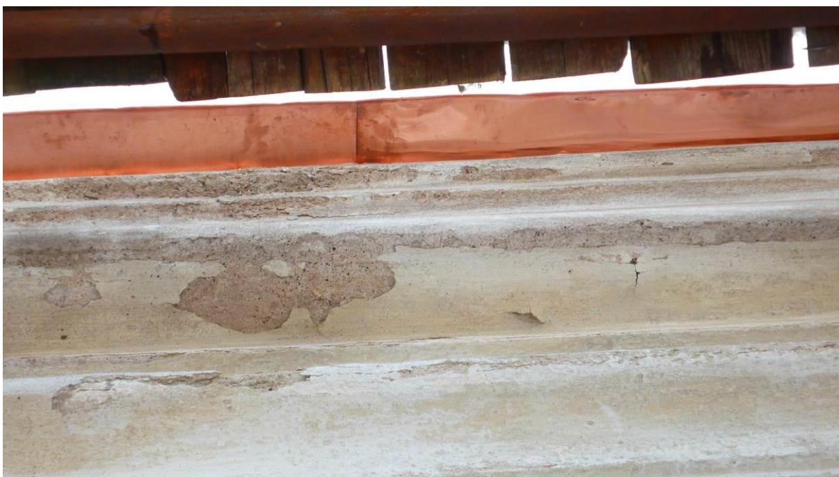
Severozápadní strana 52 Prosvítající červená vrstva
