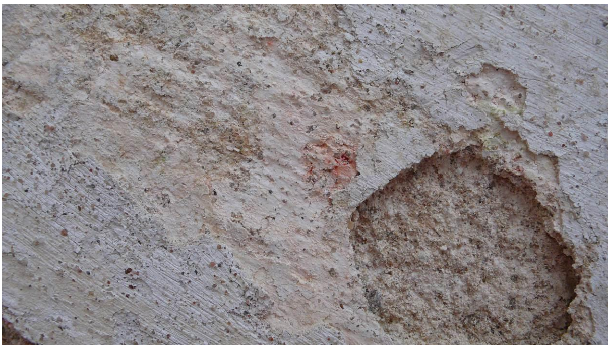
Jihozápadní strana 18 Vrchol stezky bosáže ve vnitřním prolomení fasády Prosvítající červená vrstva
