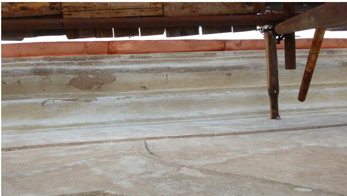
Severozápadní strana 51 Prosvítající červená vrstva
