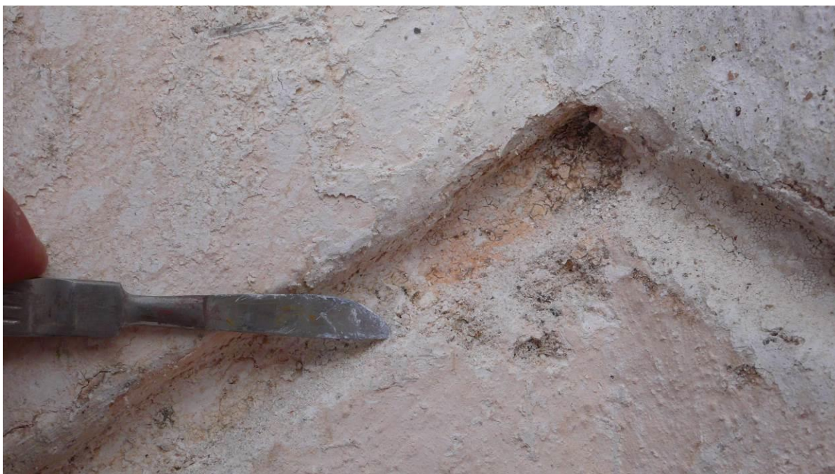
Jihozápadní strana 14 Vrchol stezky bosáže ve vnitřním prolomení fasády Prosvítající červená vrstva
