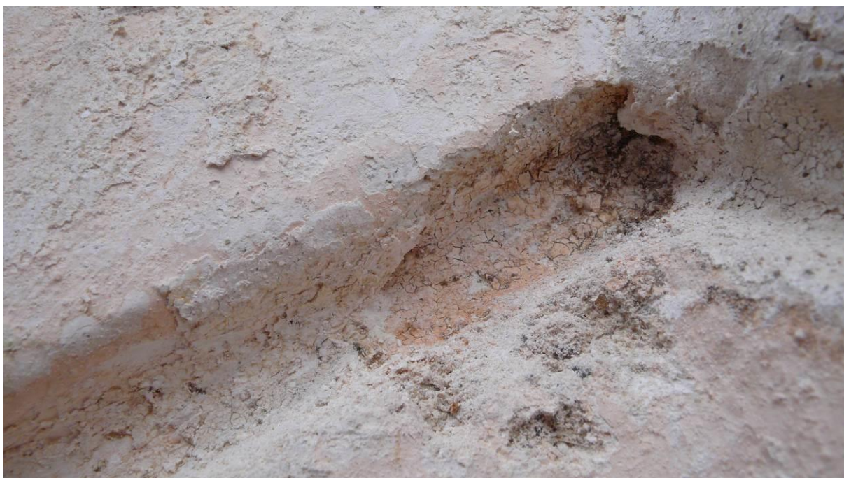
Jihozápadní strana 16 Vrchol stezky bosáže ve vnitřním prolomení fasády Prosvítající červená vrstva
