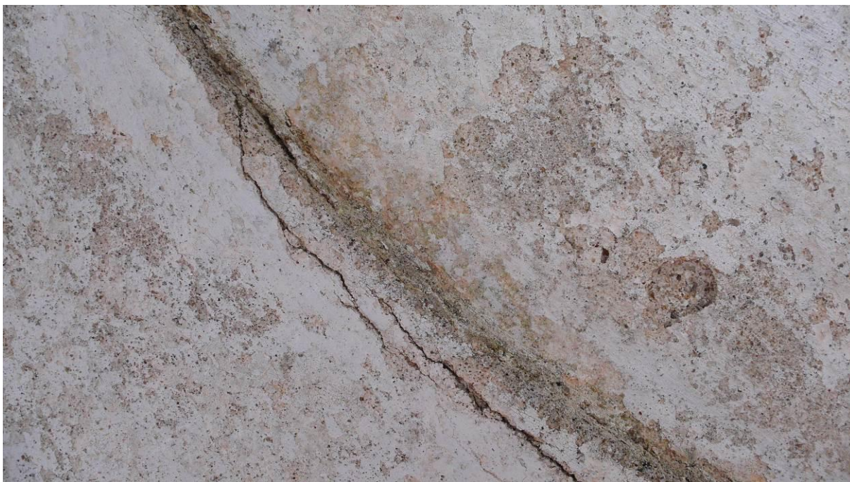
Jihozápadní strana 19 Vrchol stezky bosáže ve vnitřním prolomení fasády Prosvítající červená vrstva
