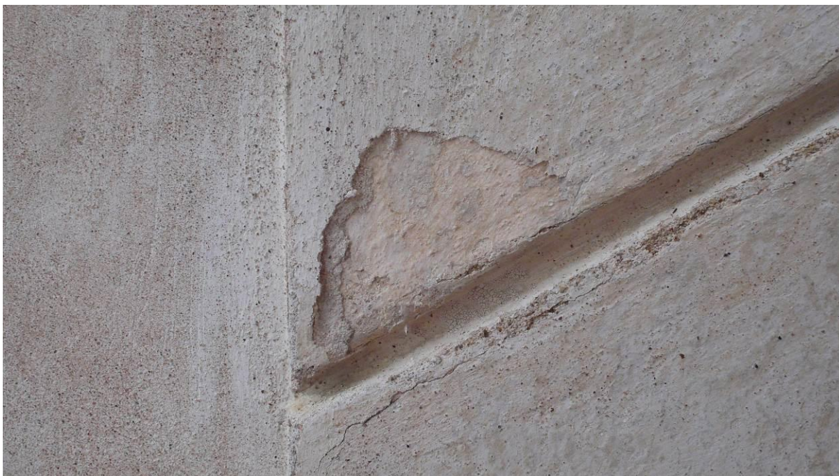
Jihozápadní strana 15 Vrchol stezky bosáže ve vnitřním prolomení fasády Prosvítající červená vrstva
