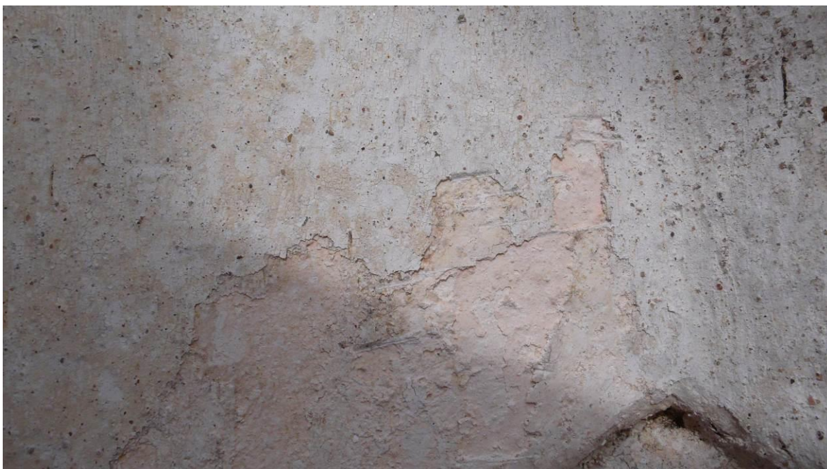
Jihozápadní strana 12 Vrchol stezky bosáže ve vnitřním prolomení fasády Prosvítající červená vrstva
