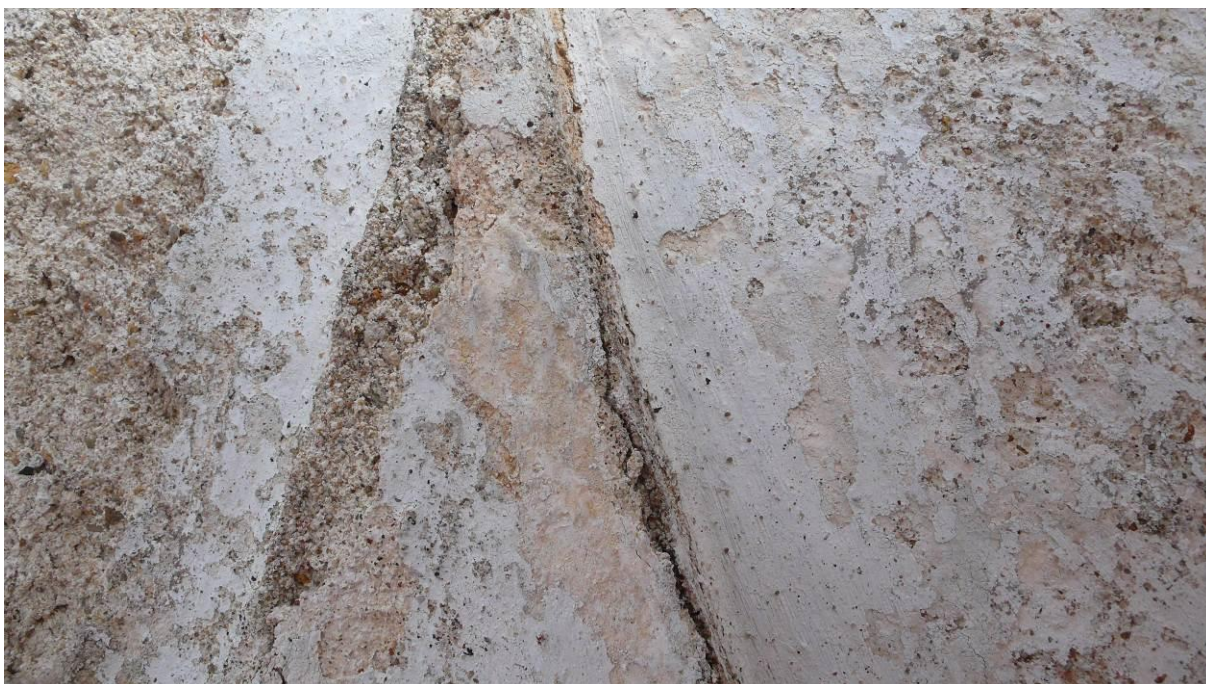
Jihozápadní strana 20 Vrchol stezky bosáže ve vnitřním prolomení fasády Prosvítající červená vrstva
