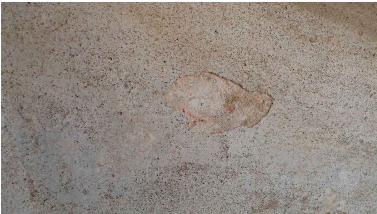
Severozápadní strana 59 Prosvítající červená vrstva
