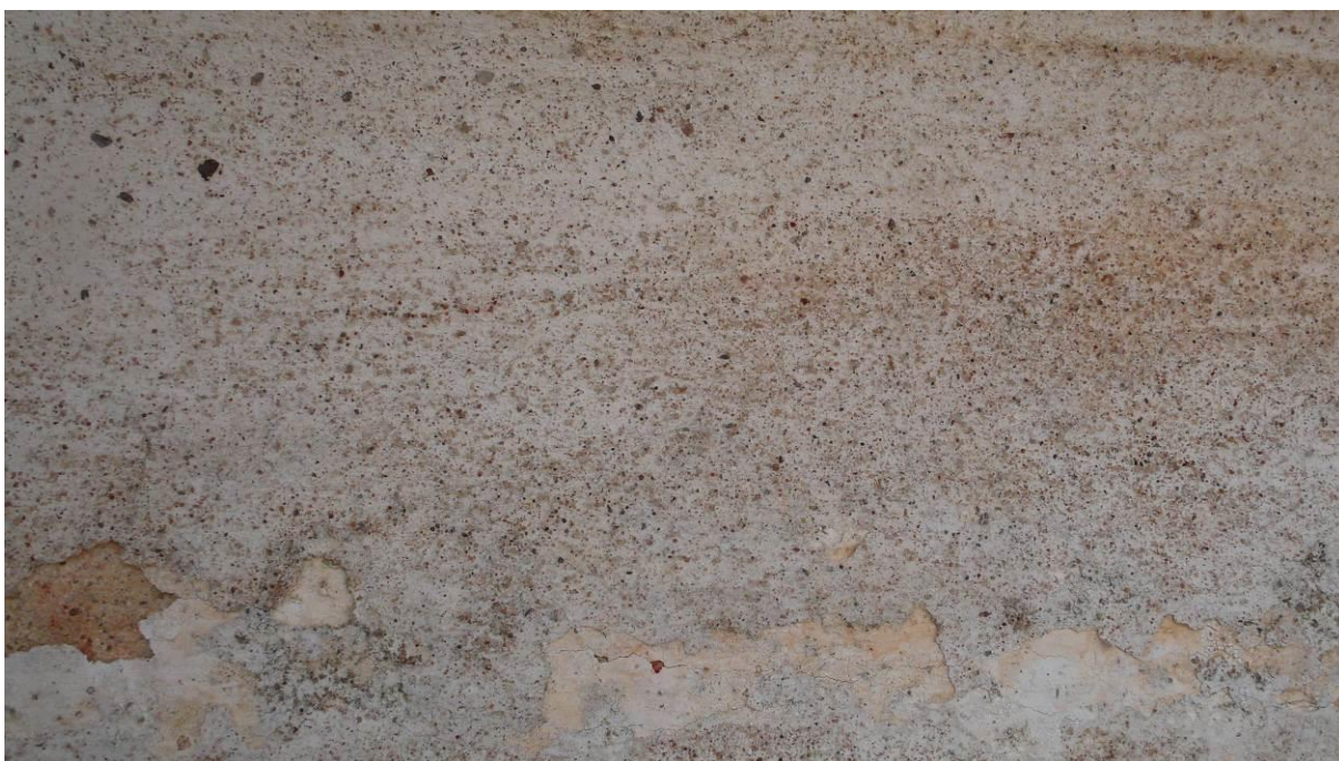
Severozápadní strana 60 Prosvítající červená vrstva
