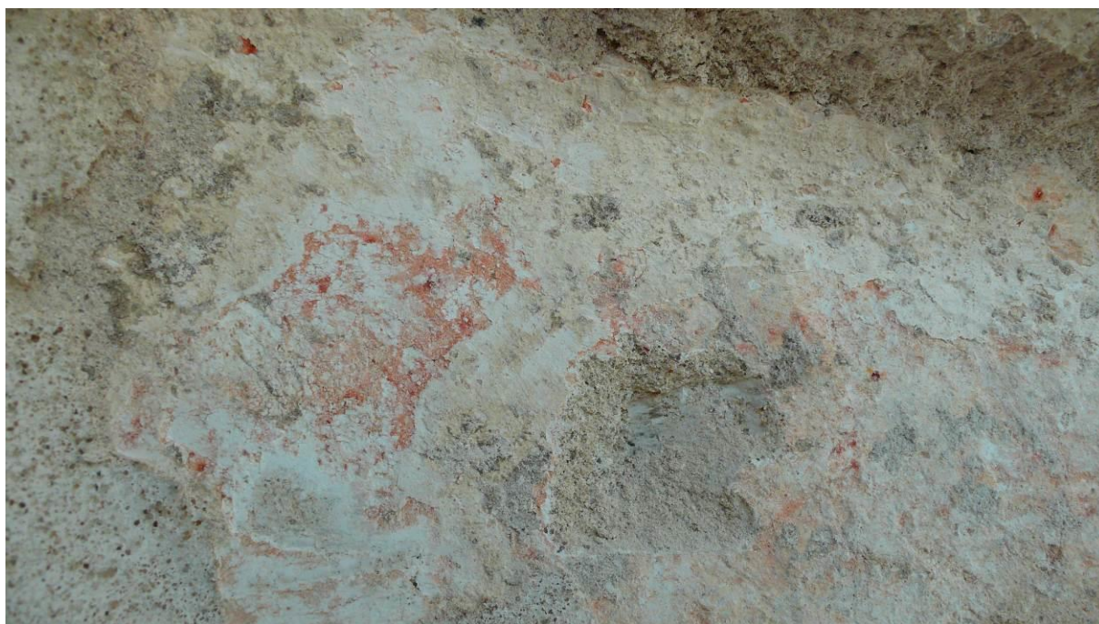
Severozápadní strana 67 Prosvítající červená vrstva
