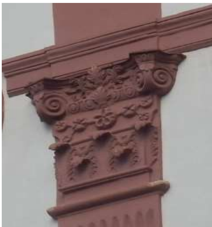
Restaurování - hlavice pilastru
