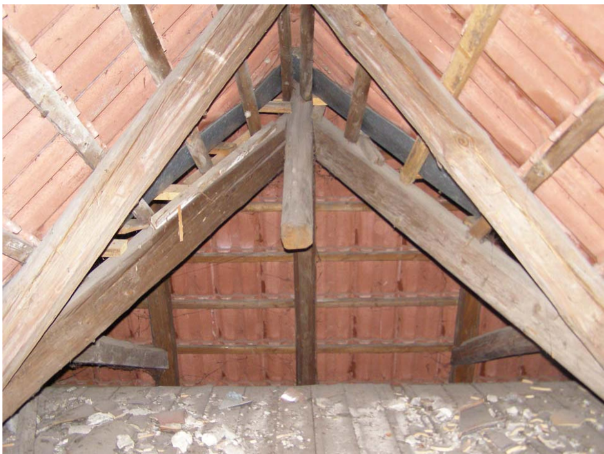
10. Krov nad dřevěným klenutým podhledem obřadní síně
