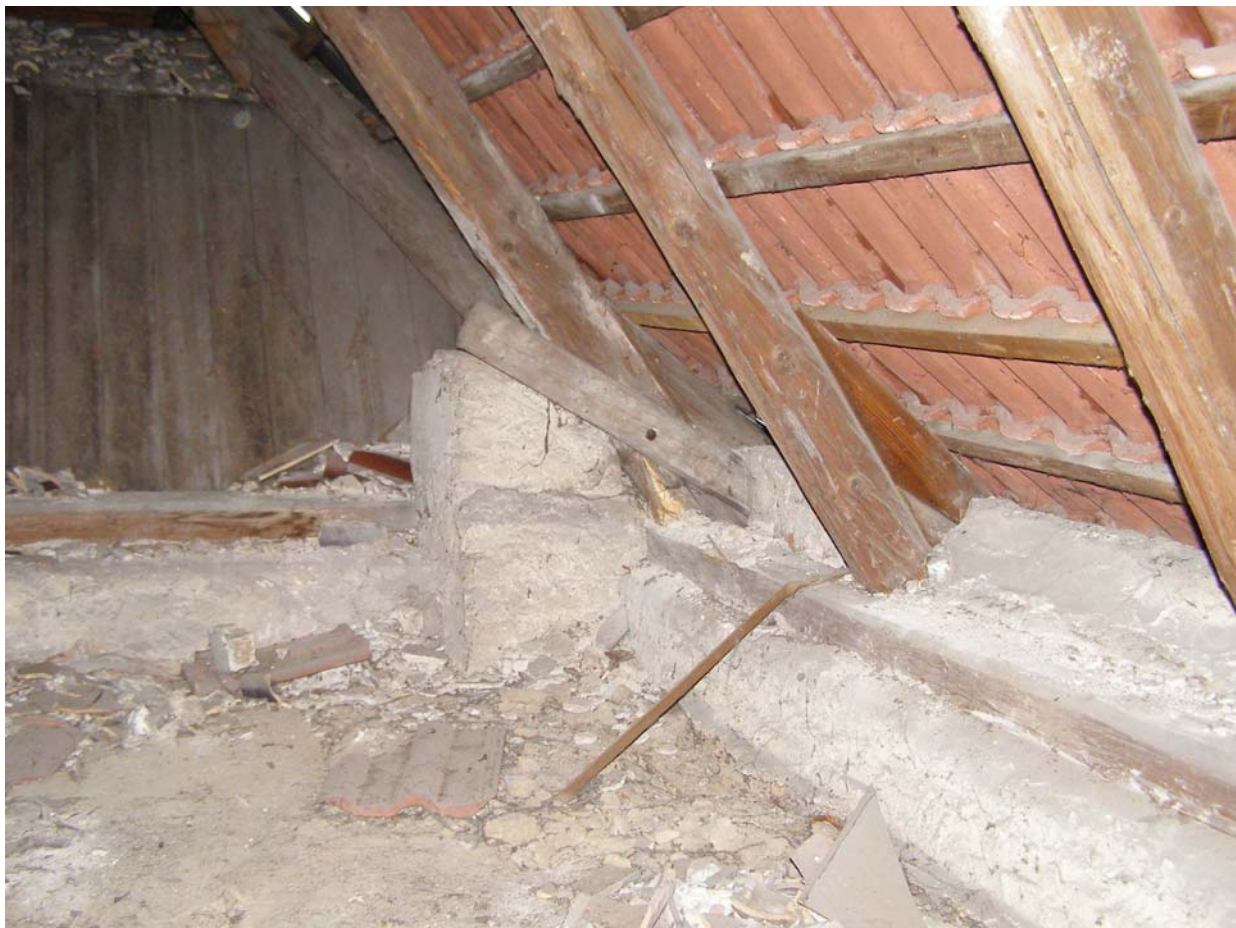
7. Krov nad márnicí
