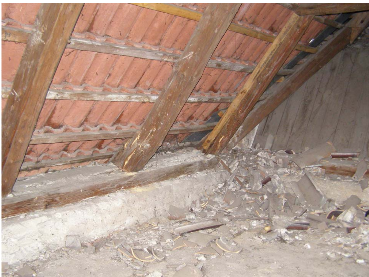
8. Krov nad márnicí
