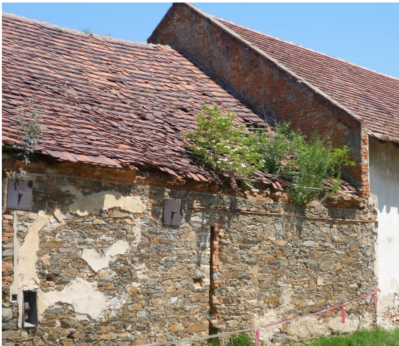
Foto objektu určeného k demolici:
