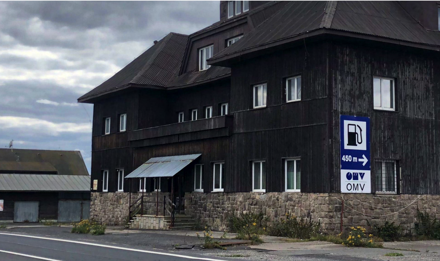
foto stávajícího stavu čelní fasády směrem od česko-německé hranice
