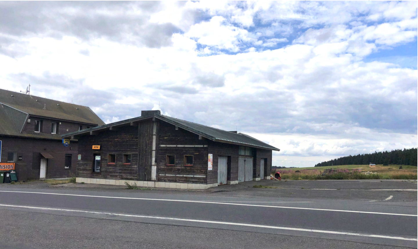
pohled na garáže (objekt C) v pozadí objekt penzionu
