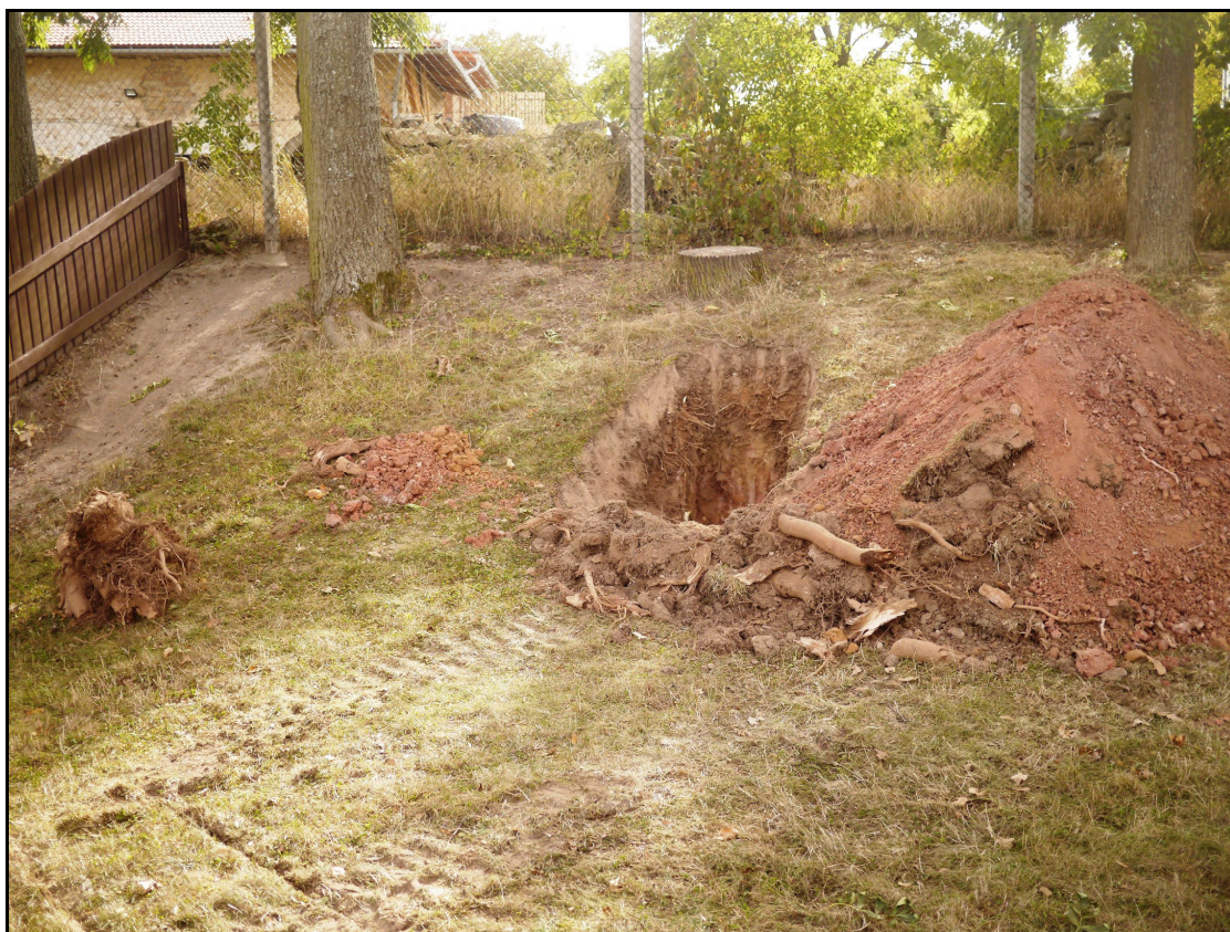
Výkop sondy B1
