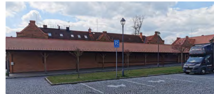
Zručský dvůr, přístřešek tržnice
