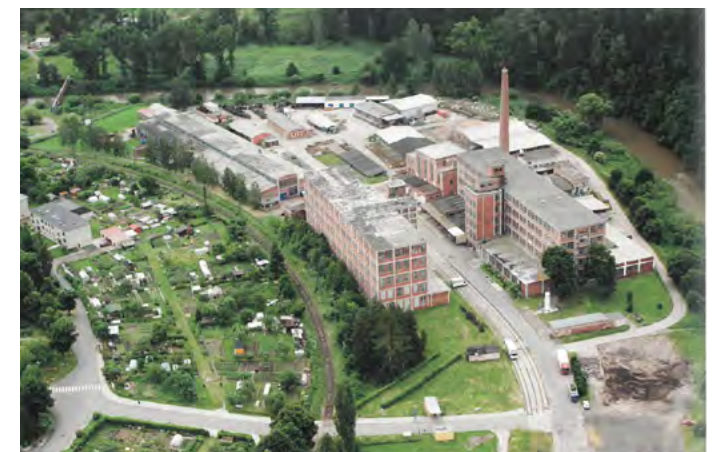
Letecký snímek areálu bývalého Sázavanu, zdroj archiv Fotoklubu Zruč .n.S
