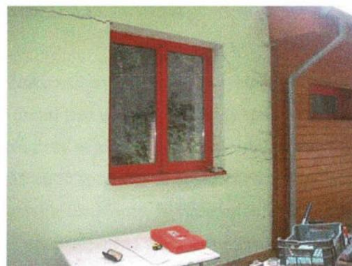
Na objektu byly patrné trhliny ve zdivu z vnitřní a místy také z vnější strany. Pohled na vnější stranu byl omezen v severozápadní části dřevěným obkladem, pod nímž byly trhliny velmi pravděpodobně skryté. Na východní stěně měly trhliny především vodorovný směr s prokreslením kopírujícím skladbu cihel. Pokles jednotlivých stěn se místy projevil i na konstrukci stropu nebo do oblasti zpevňujícího věnce.
