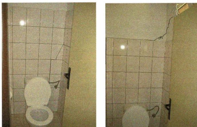
Trhliny byly většinou otevřené, v některých místech opravované. Podle informací provozovatele objektu se po opravě některých trhlin tyto poměrně rychle obnovily. Přesné záznamy o časovém sledu však nebyly v době průzkumu k dispozici.
