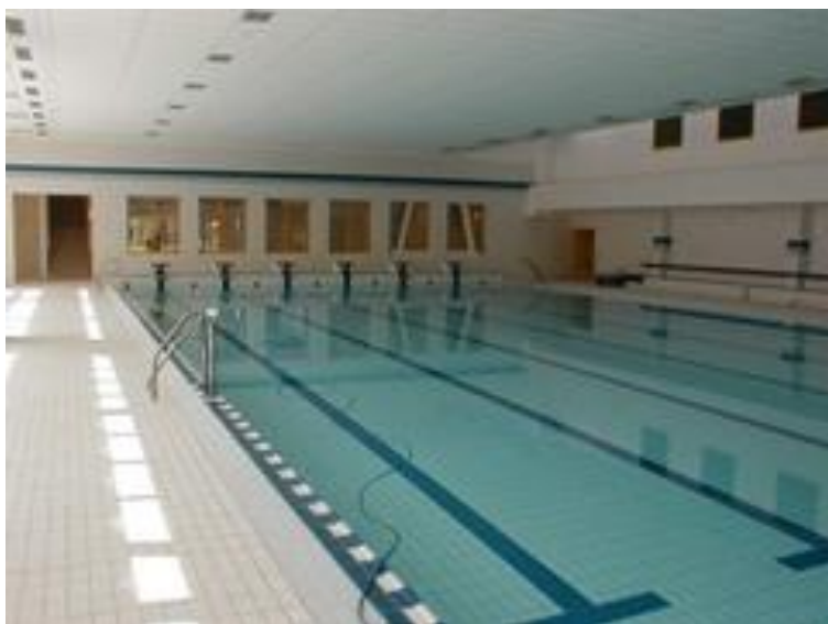
Obrázek 46 – Aquapark Vyškov – plavecký bazén (zdroj: www.google.com )
