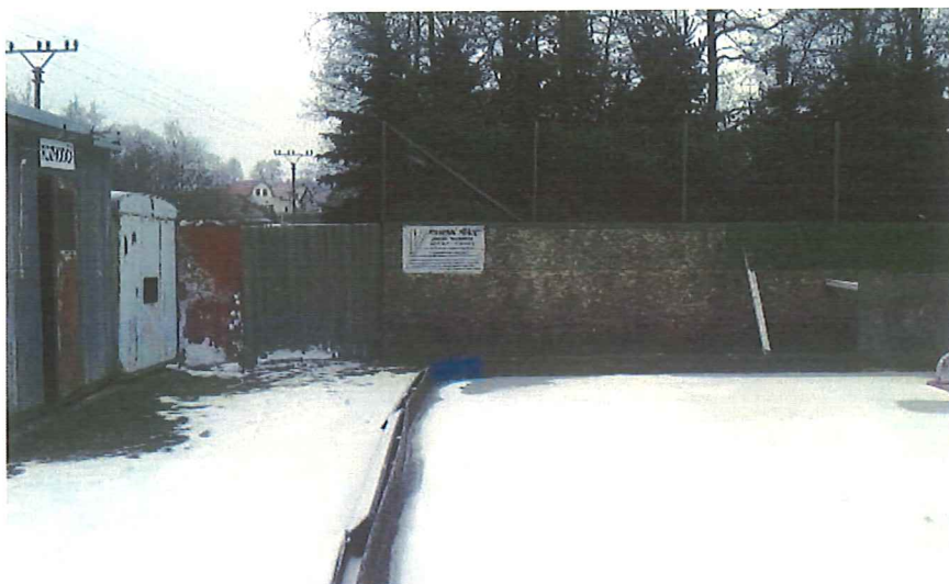
Foto stávající stav
