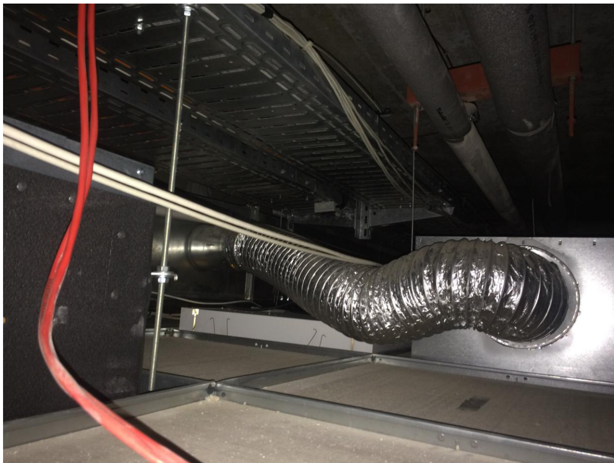
Obr. 2 anemostat přívodu vzduchu v podhledu 1.NP
