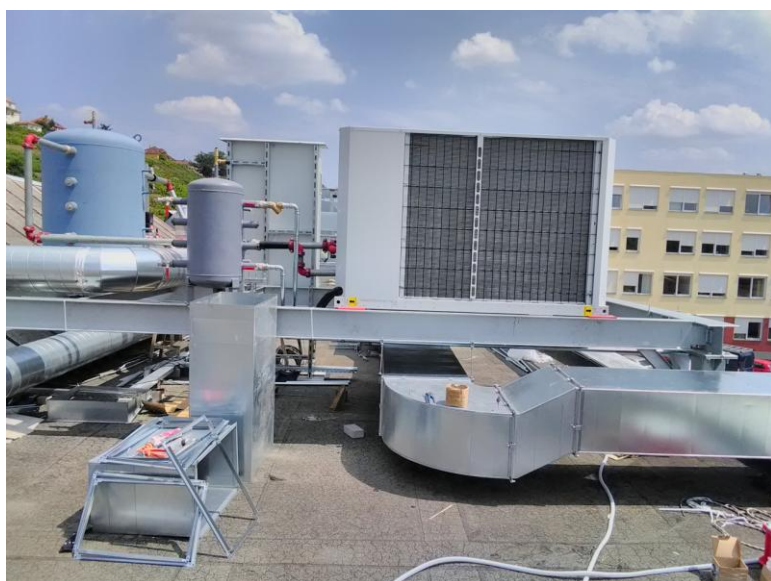
Obr.6 bloková chladicí jednotka během montáže
