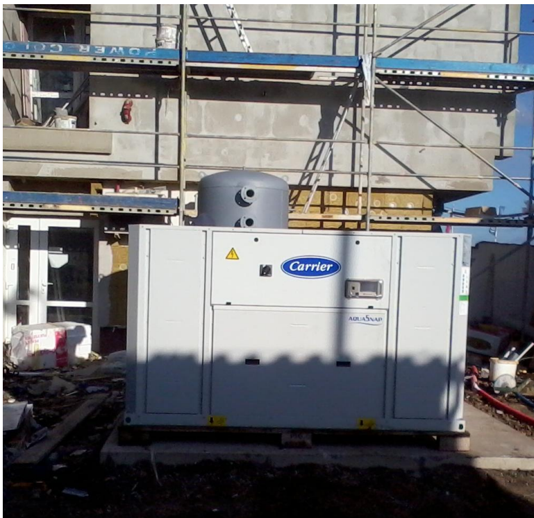
Obr. 7 - jiný příklad instalace centrální blokové chladicí jednotky
