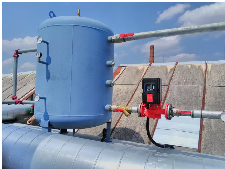
Obr.5 - akumulční nádoba bez izolace
